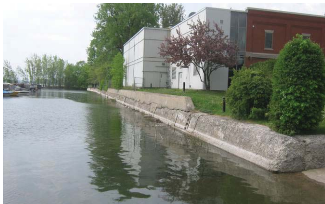
Photo 24 : Muret de béton délimitant le bassin de la marina avec l'usine de filtration d'eau potable municipale. Regardant vers le sud (2016-05-27).
