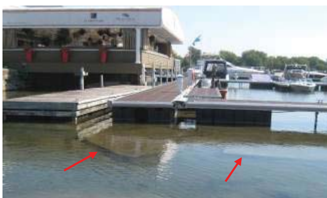
Photo 6 : Blocs de béton submergés servant d'ancrage aux pontons flottants C et D.
