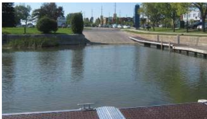
Photo 3 : Rampe de mise à l'eau municipale dans la partie nord-ouest du bassin.
