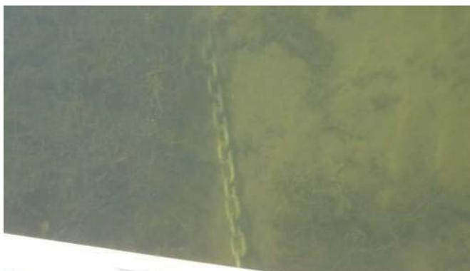
Photo 10 : Chaîne en acier galvanisé reliant les pontons aux blocs de béton servant d'ancrage.
