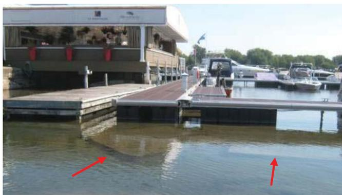
Photo 9 : Blocs de béton submergés servant d'ancrage aux pontons flottants C et D. Regardant vers l'est.
