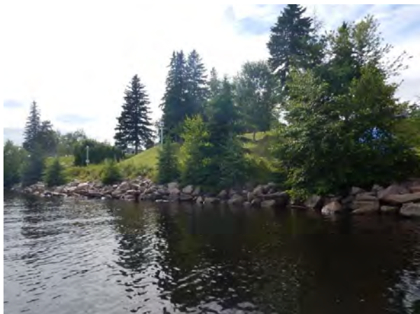
Photo 23. Segment 3 – enrochement en rive
