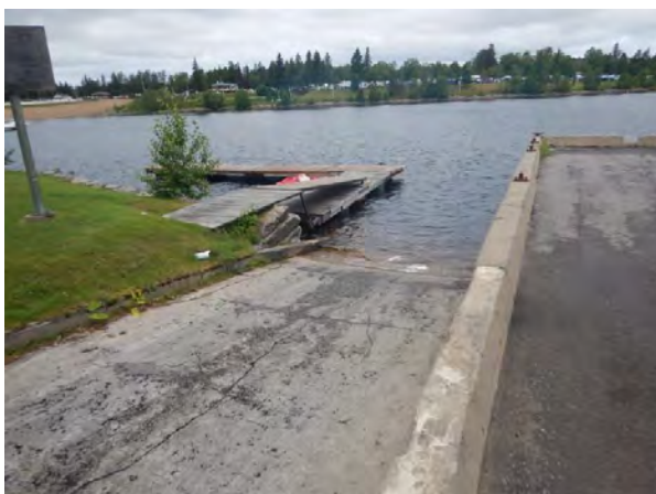
Photo 7. Rampe de mise à l'eau – quai municipal
