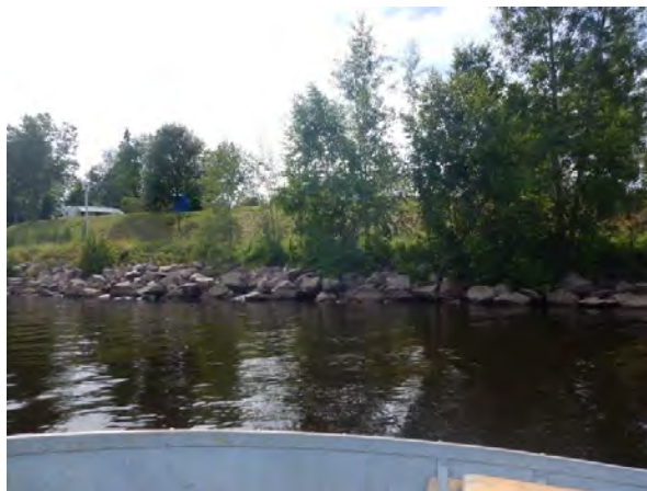
Photo 24. Segment 3 – enrochement en rive
