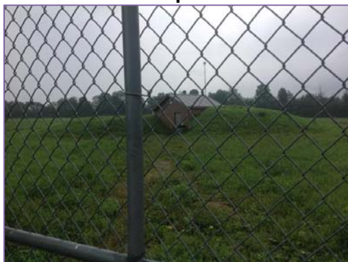
Photo 3-4 Bâtiment abritant la prise d'eau de la montée Byrne
