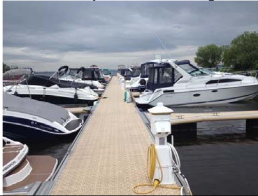
Photo 2-4 : Vue des places d'amarrage des bateaux
