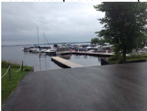
Photo 2-2 : Rampe de mise à l'eau et quais de la marina (vue en direction de l'est)
