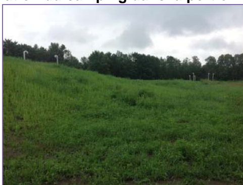
Photo 3-5 Champ d'épuration du camping dans la portion nord de la montée Byrne
