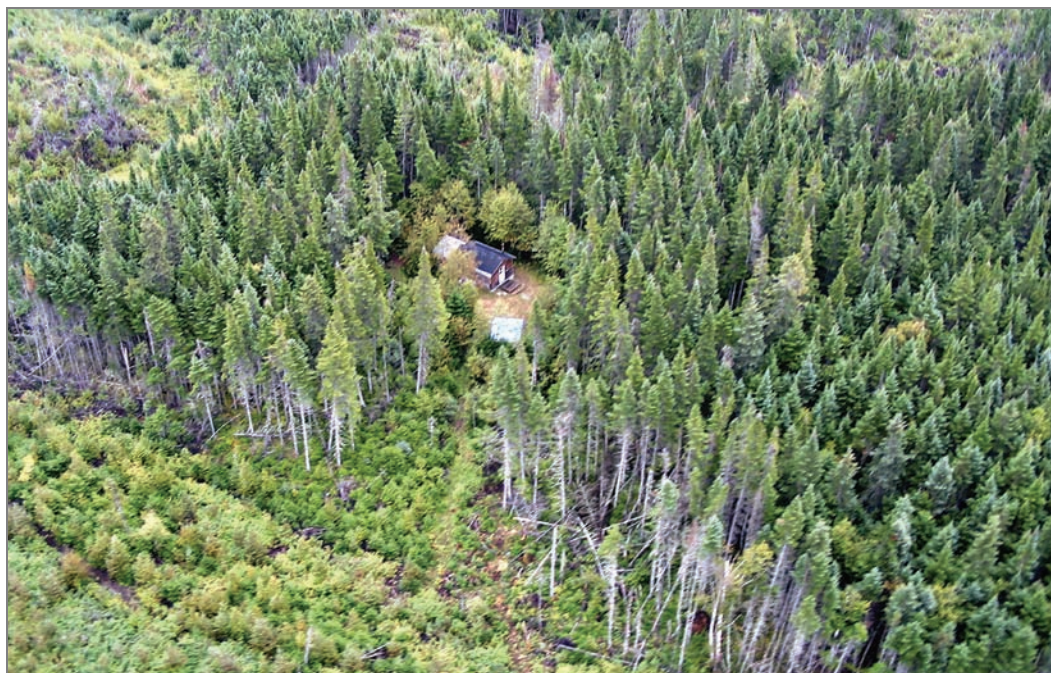
Photo 7-15 : Camp sur la rive droite de la rivière des Rapides, à 440 m au sud du tracé de la ligne de la Romaine-2–Arnaud (feuillet 9 de la carte 3)
