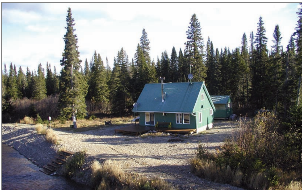
Photo 7-6 : Chalet avec bail sur la rive gauche de la rivière Manitou, à 220 m au sud du tracé de la ligne de la Romaine-2–Arnaud (feuillet 6 de la carte 3)
