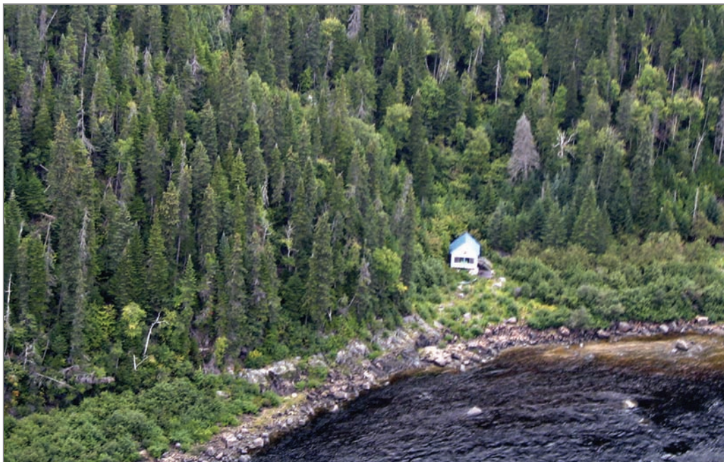
Photo 7-13 : Camp sur la rive droite de la rivière Moisie, à 410 m au sud du tracé de la ligne de la Romaine-2–Arnaud (feuillet 9 de la carte 3)
