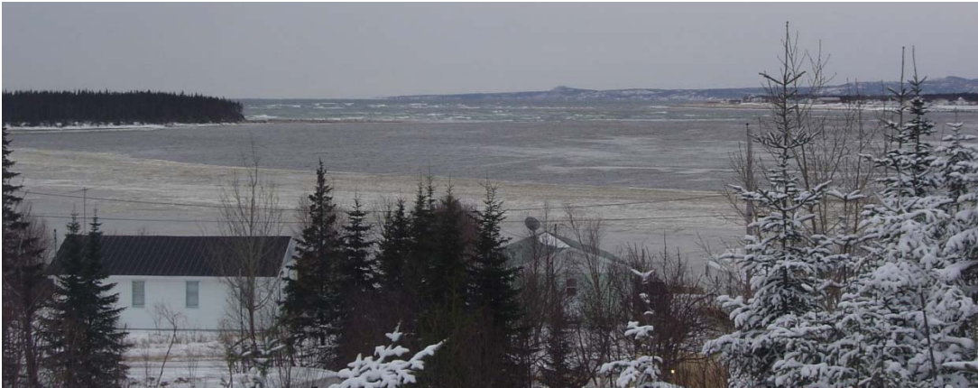
Photo 2: La protection naturelle de la flèche pour les propriétés à l'embouchure se détériore avec l'érosion de la falaise du boisé.
