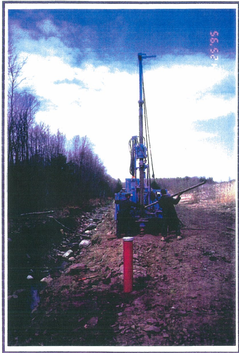
Photo # 1: Foreuse à carré évidé utilisée pour la majorité des forages. À l'avant plan ,le piézomètre 11B est déjà installé en bordure du ruisseau qui longe la portion nord ouest du site
