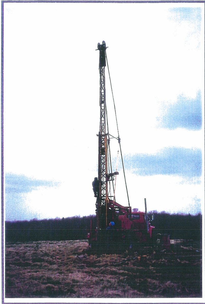
Photo # 2: Foreuse de type batteuse utilisée pour la réalisation du forage #10 traversant la couche de déchets.
