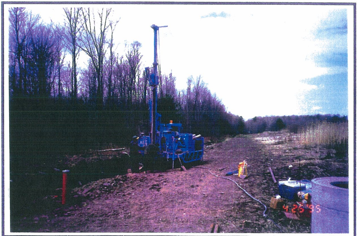
Photo # 4: Dans le secteur des forages # 11 , on remarque un trou d'homme abritant le réseau de captage du lixiviat.
