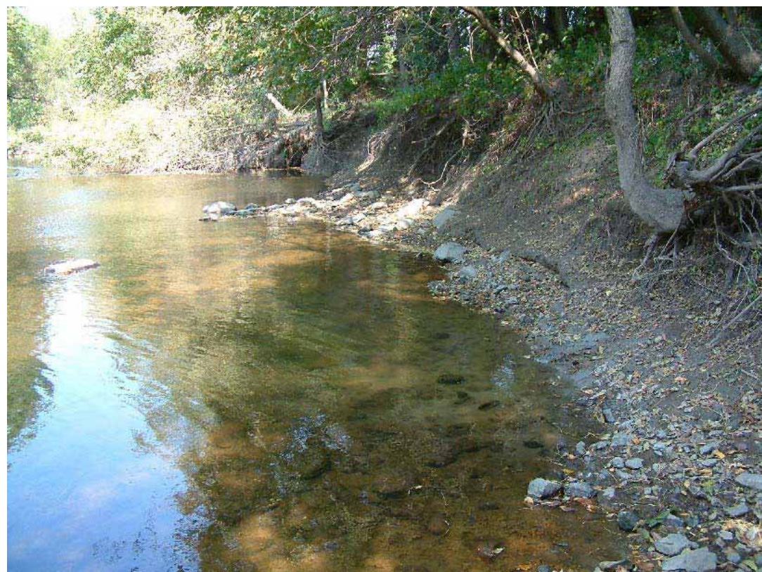
Photo n° 3. ↑ Érosion des berges, station MAW-02
