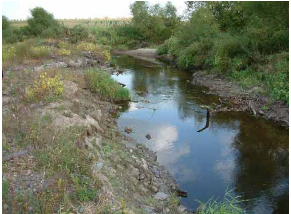
Photo n° 18. Érosion des berges de la station MAW-04
