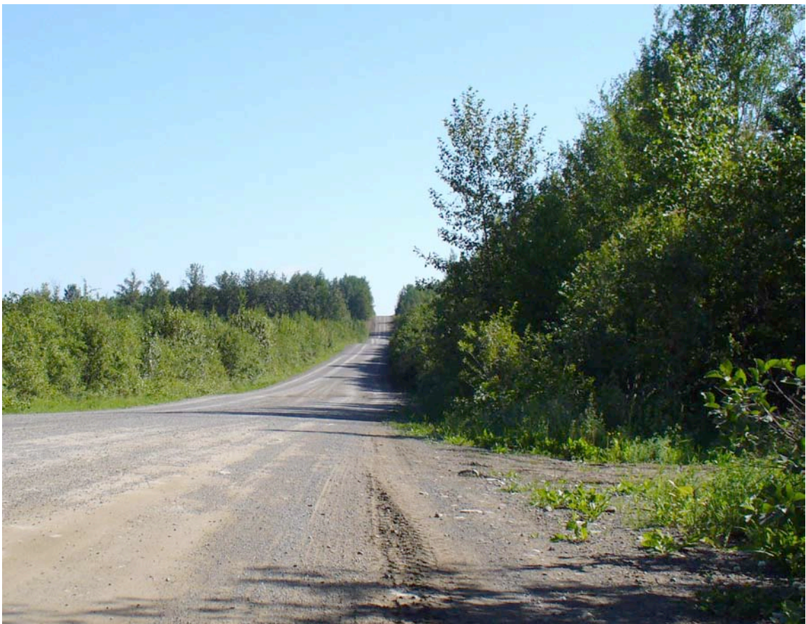
Photo du Rang 8 prise près de la position de la future entrée du site d'enfouissement en direction du village de La Rédemption
