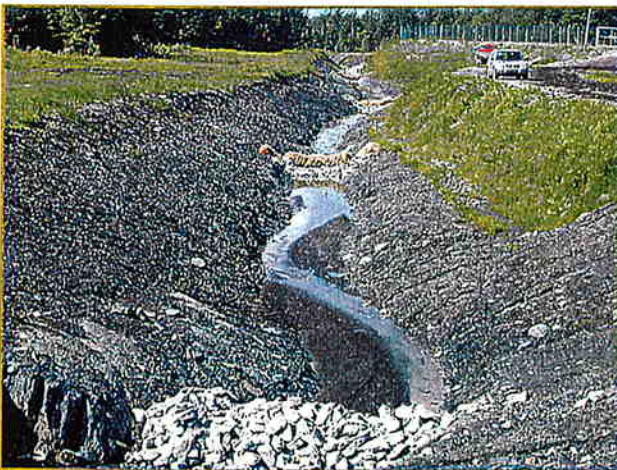
Vue générale du fossé sud où ont été aménagés les barrières physiques de sédimentation.
