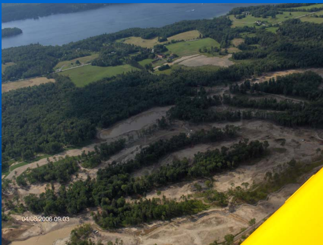
Golf en construction, Magog, 4 août 2006. Photo MCI
