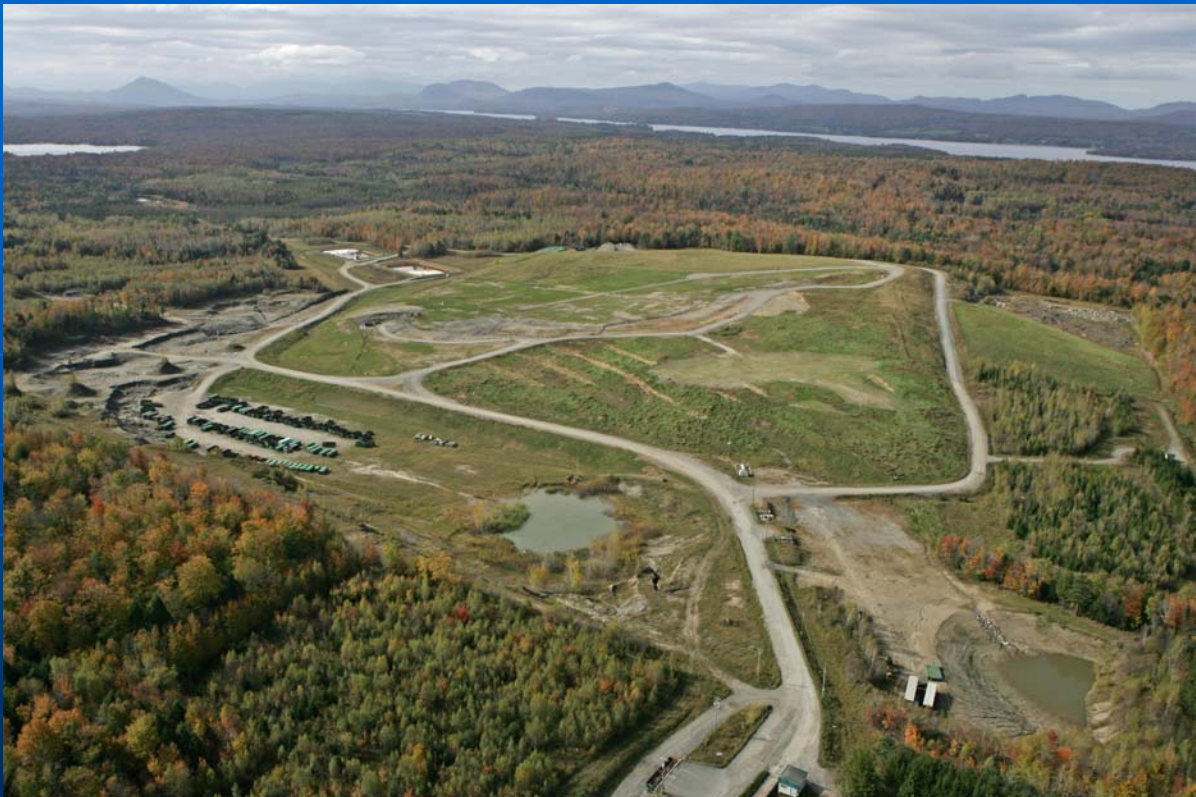
Site d'enfouissement, Magog, photo Hélico inc.
