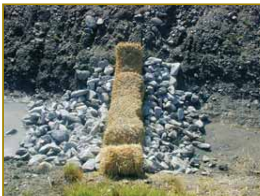
Vue en plongée de l'aménagement d'un muret de pierre et des ballots de paille.
