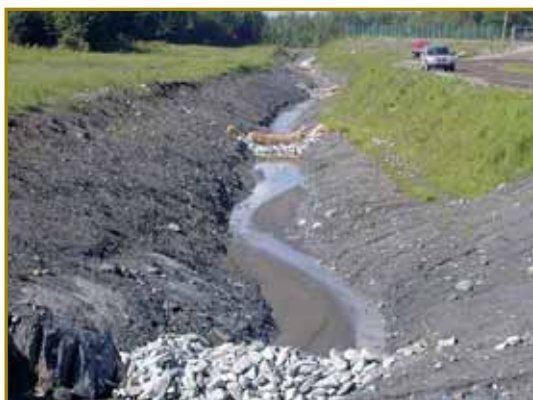
Vue générale du fossé sud où ont été aménagés les barrières physiques de sédimentation.
