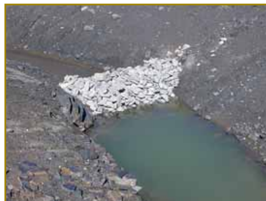
Vue en plongée du muret de pierre.
