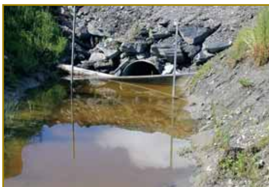
Barrière de géotextile retenant les sédiments avant l'arrivée des eaux au ponceau.
