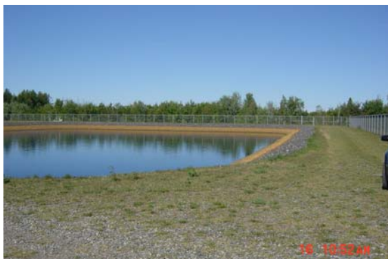
FIGURE 6 - BASSIN TYPE D'ACCUMULATION DU LIXIVIAT
