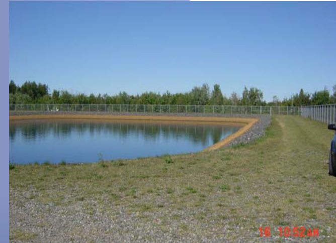
Bassin d'accumulation typique
