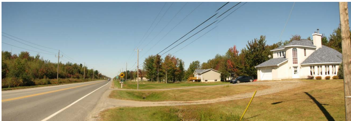
Photo 5.12 Vue à partir du boulevard Saint-Joseph près de la rue des Sables
