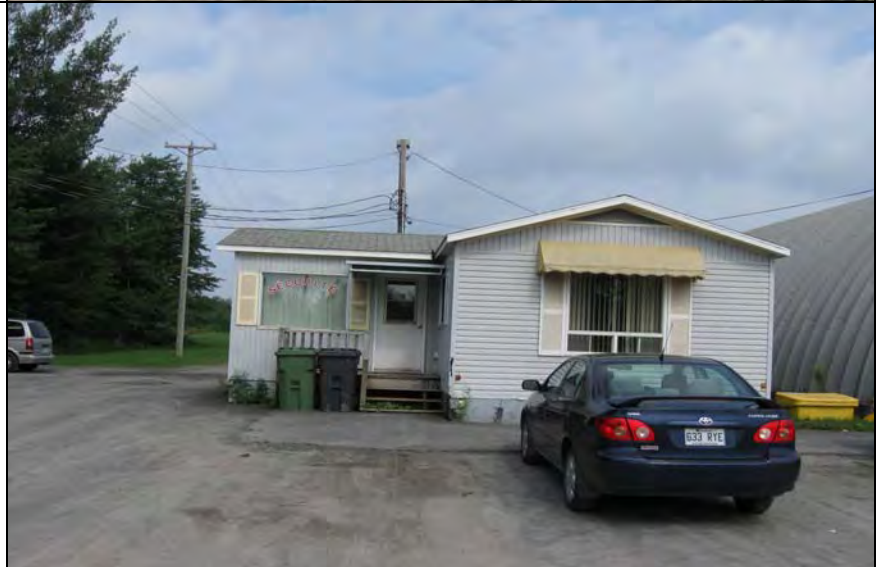
Entrée du site entre les bureaux administratifs et le garage
