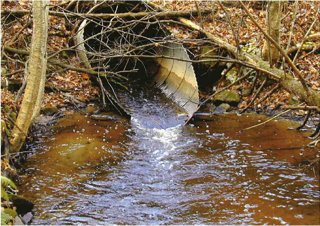
17. Localisation du point de mesure 11 (ponceau avant le rejet à la Rivière St. François) / Location of the measuring point 11 (culvert, before discharge into the St. François River)
