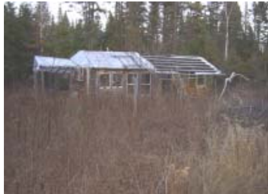
Figure 2.5 Camp détérioré situé dans un rayon de 1 km Source : Rock Pratte
