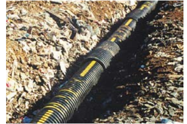
Tranchée horizontale où est installé le réseau de collecte des biogaz.
