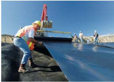
Mise en place d'une géomembrane sur la paroi d'une cellule.
