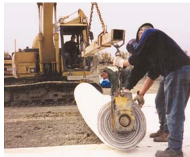
Mise en place de la natte bentonite imperméable.
