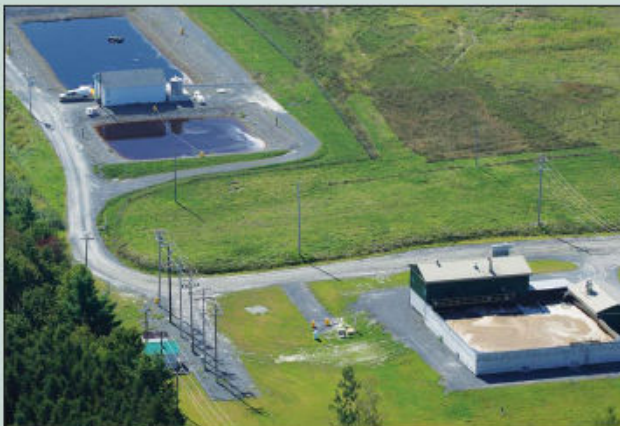
La nouvelle station de traitement des eaux de lixiviation (située dans le coin droit en bas de la photo) permet de renforcer la protection environnementale du site.
