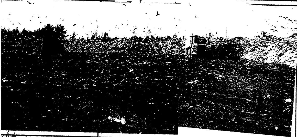
Photo 1) Opération d'enfouissement sur la phase II de l'exploitation.
