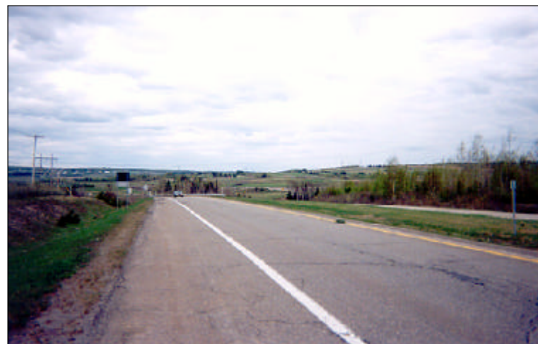
Photo E : mai 2001 Rue de Lausanne. Vers le sud.
