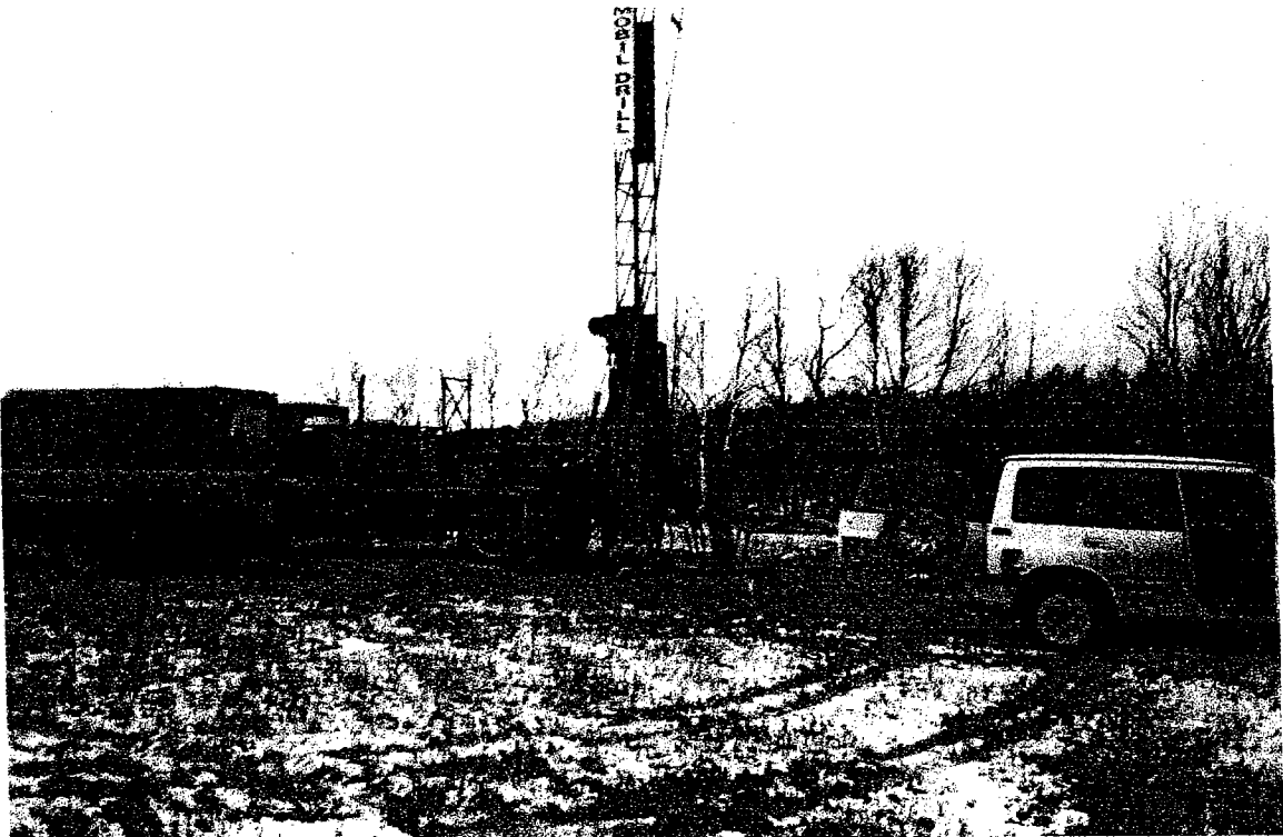
Photographie 3 : Réalisation d'un forage aux tarières évadées
