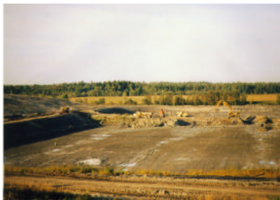
Figure 5.1 Travaux type d'excavation d'un LET
