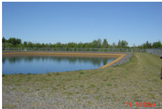
Figure 3.5 Bassin type d'accumulation du lixiviat
