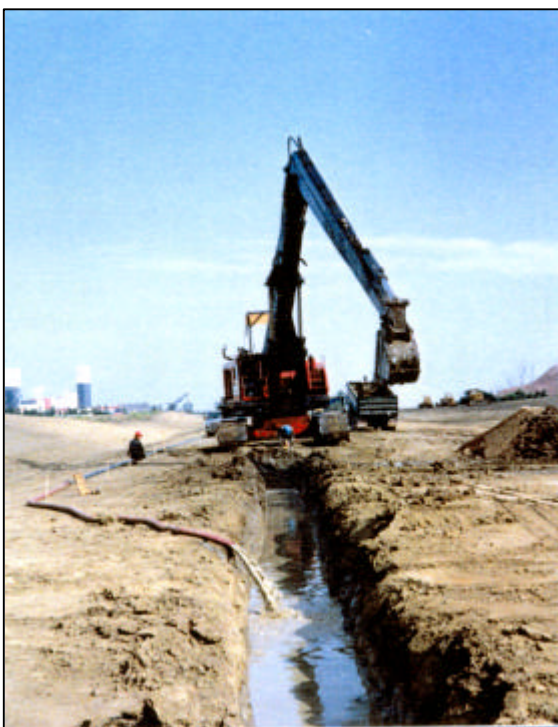
Figure 3.4 Construction d'un écran d'étanchéité périphérique
