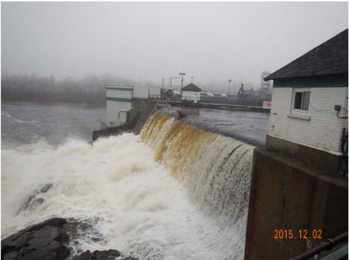
Photo 10 : Déversoir (chute d'eau)
