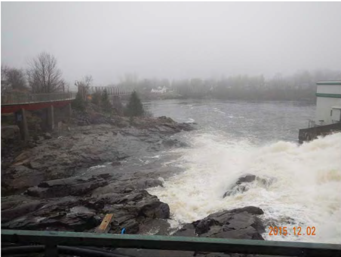
Photo 5 : Bassin en aval de l'évacuateur et du déversoir
