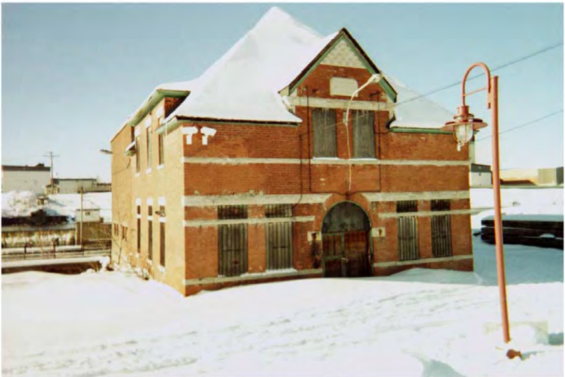
Photo 8 : Château d'eau – Façade
