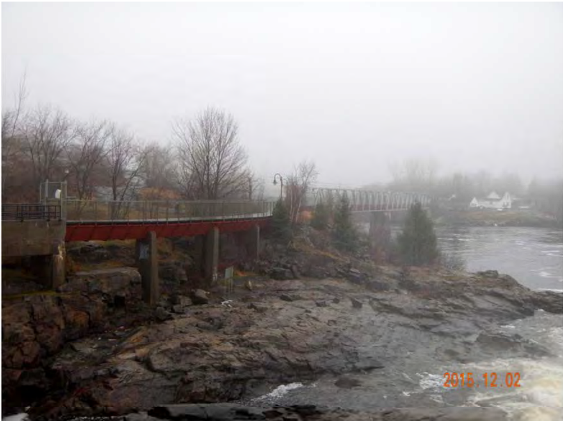
Photo 4 : Arboriduc (aval du barrage de Buckingham)
