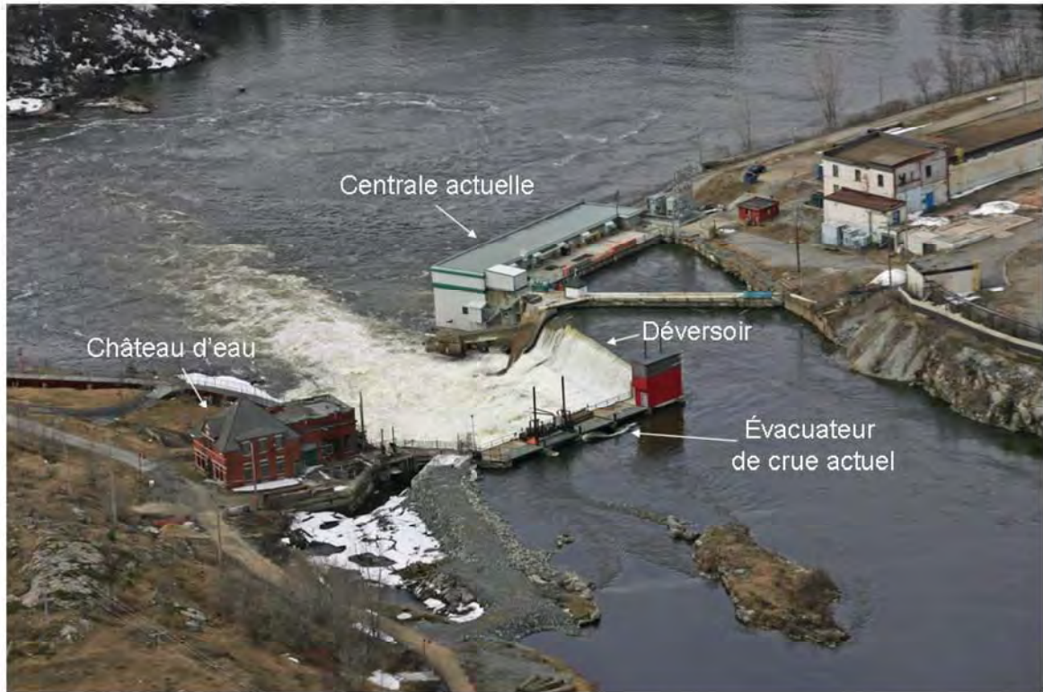
Figure 5 Installations de la centrale de Buckingham (vue amont) avant les travaux
