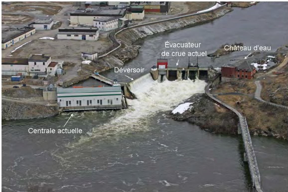
Figure 4 Installations de la centrale de Buckingham (vue aval) avant les travaux
