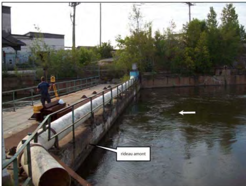
Figure 19 Photo de l'écumoire et du rideau à démanteler
