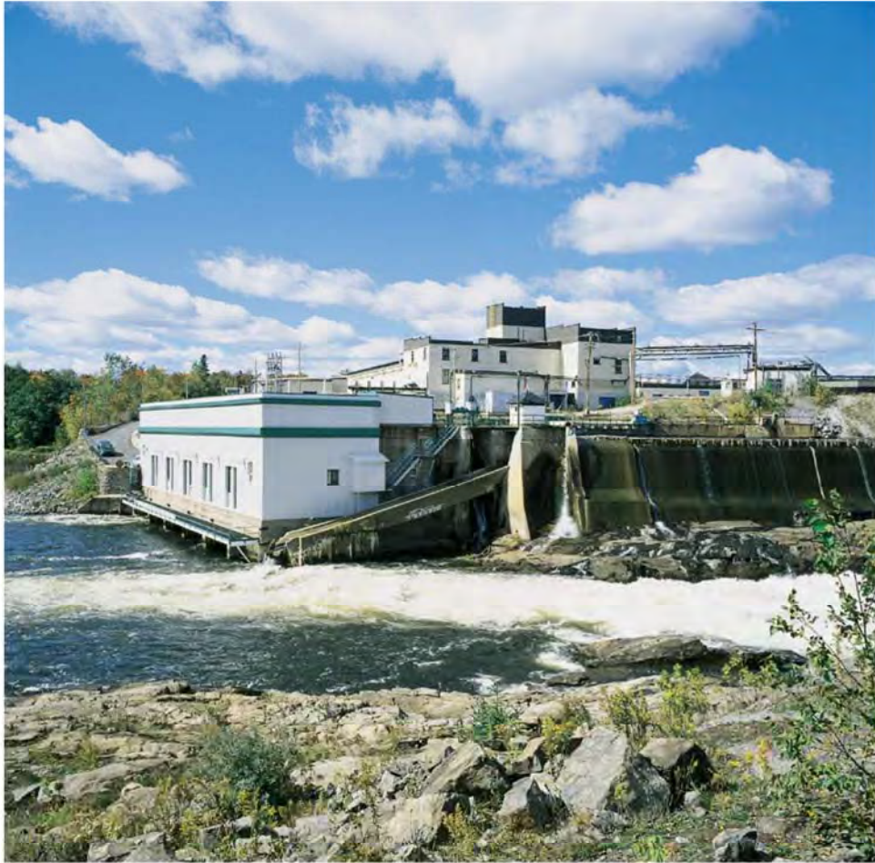
Photo 1 : Rive gauche – Centrale de Buckingham
