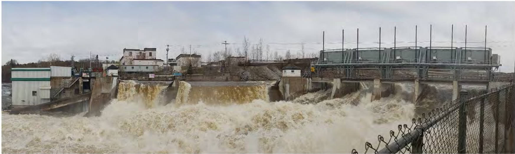
Figure 6 Installations actuelles du barrage (Mai 2017)
