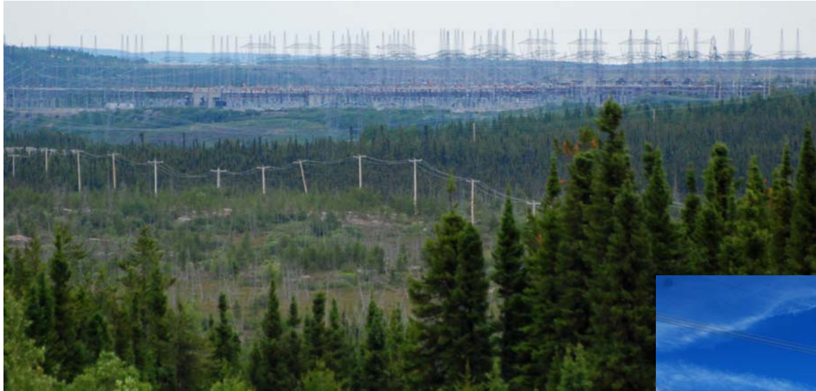
Baie-James. Pylônes et fils au nord.
