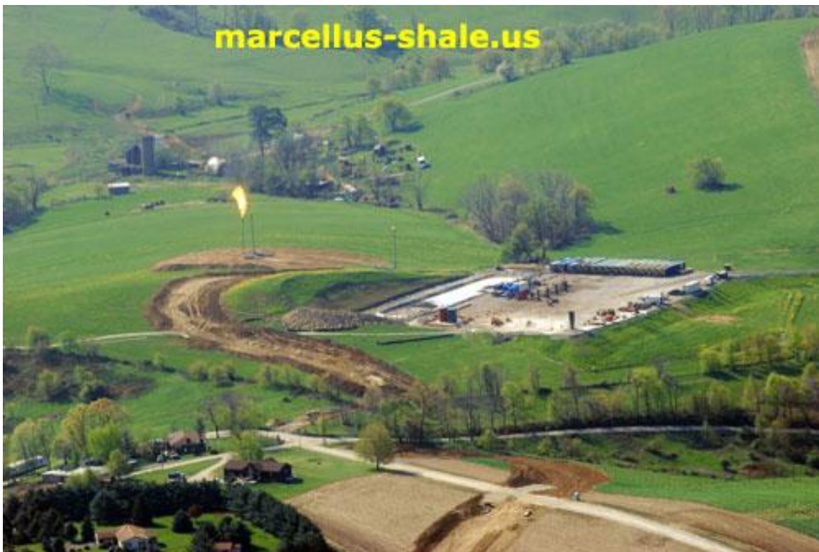
Photo 16 : Image d'un puit de forage en cours de fracturation dans l'état de New York
