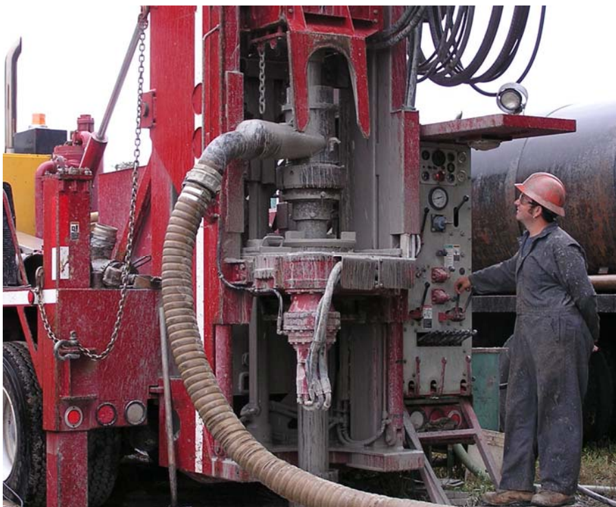
Figure 2 — Installation d'un puits de surveillance des eaux souterraines
