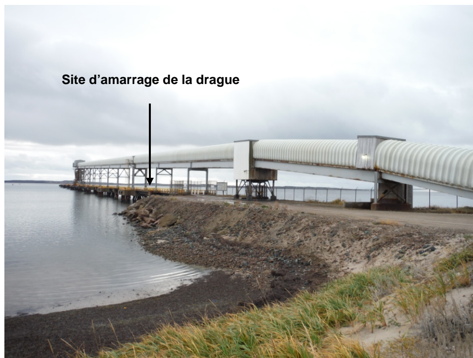
Photo 4 – Site d'amarrage de la drague lors du déchargement en milieu terrestre (N/Réf. 061)
