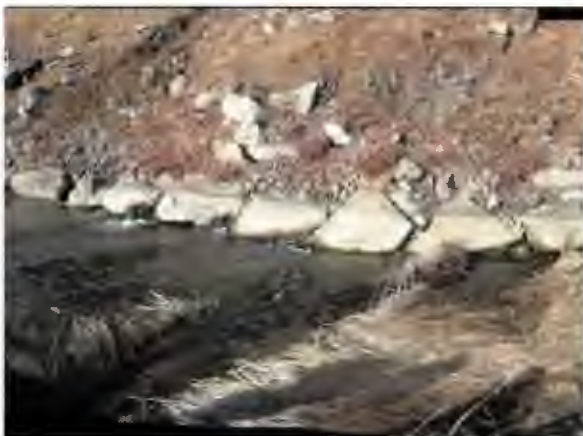
Photo 3.37 – Bassin du DJ-CED-740
