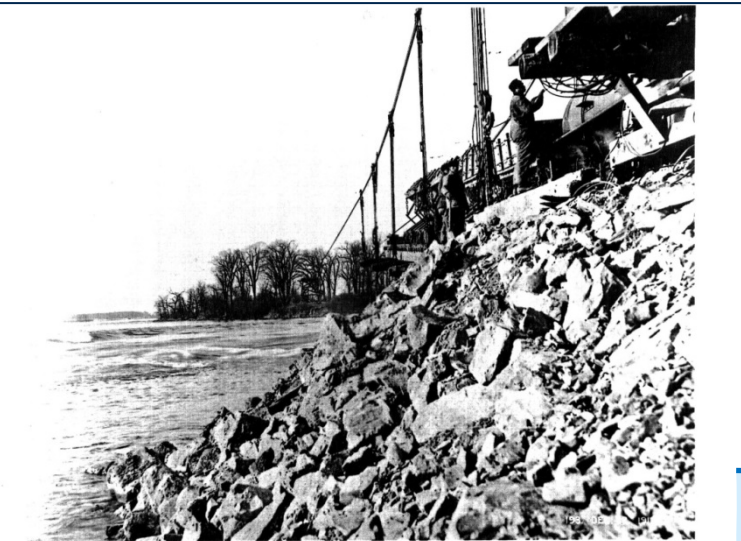
Figure 54. Déversement de l'enrochement à l'aide de la "cableway" Vue vers l'île aux Vaches le 22 décembre 1913
