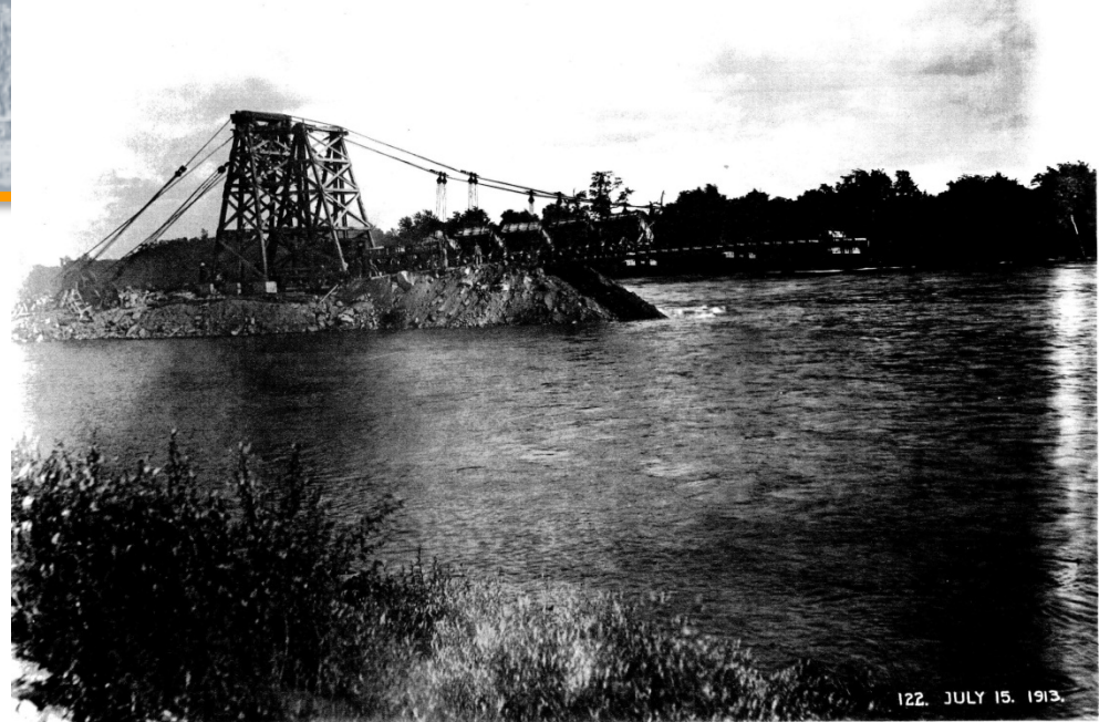
Photo 8 Remblayage de la dique en rive droite entre l'évacuateur bétonné et l'île Aux Vaches
