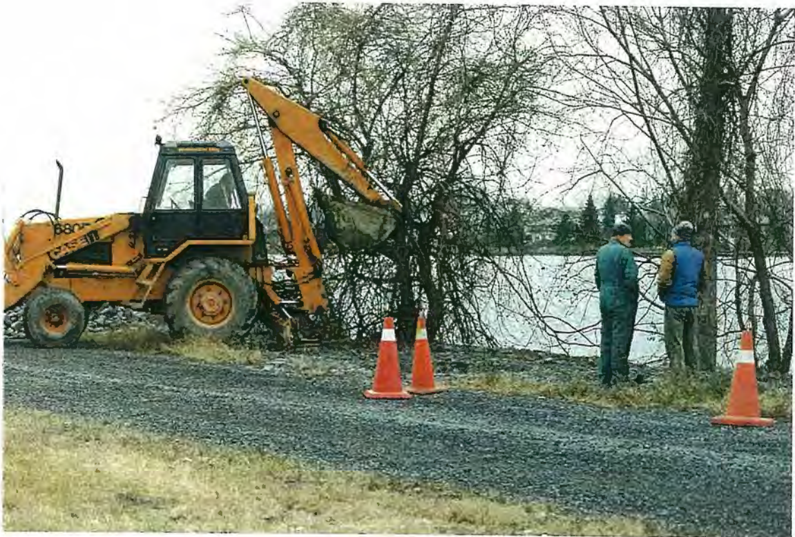
Photo 1: Tranchées creusées perpendiculairement au parement amont de la digue Les Cèdres.
