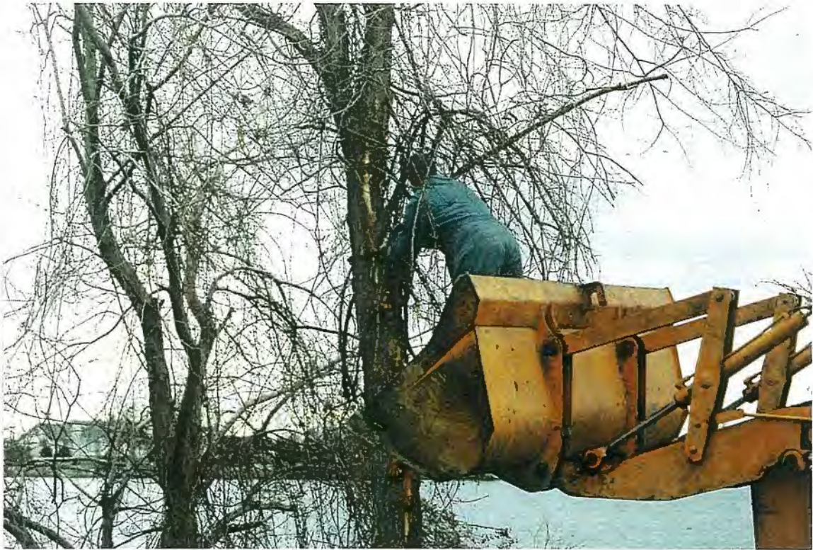
Photo 3: Chainage de l'Orme d'Amérique en vue de faciliter son déracinement.
