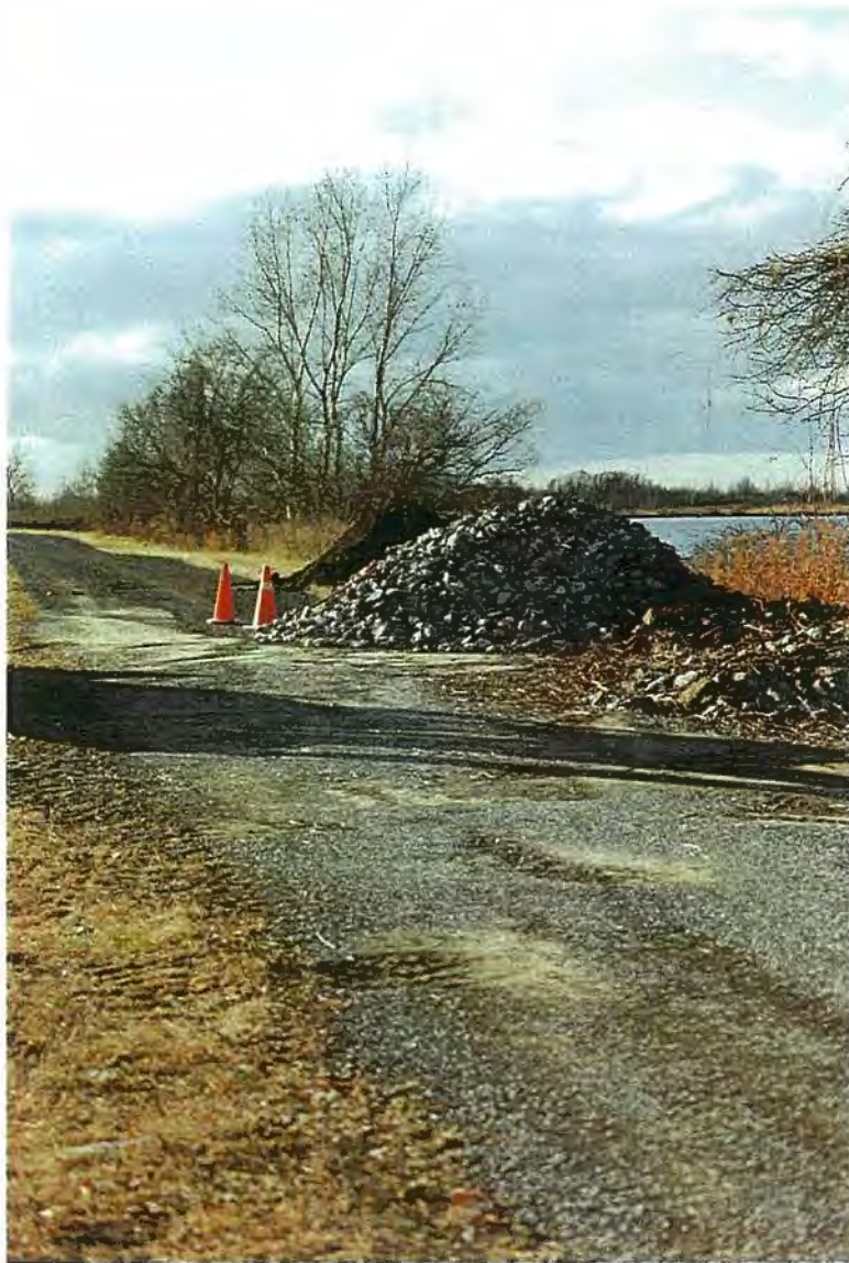
Photo 5: Matériel de remblaiement: Au premier plan: pierre concassée de diamètre 112-230 mm; en arrière-plan: argile.
