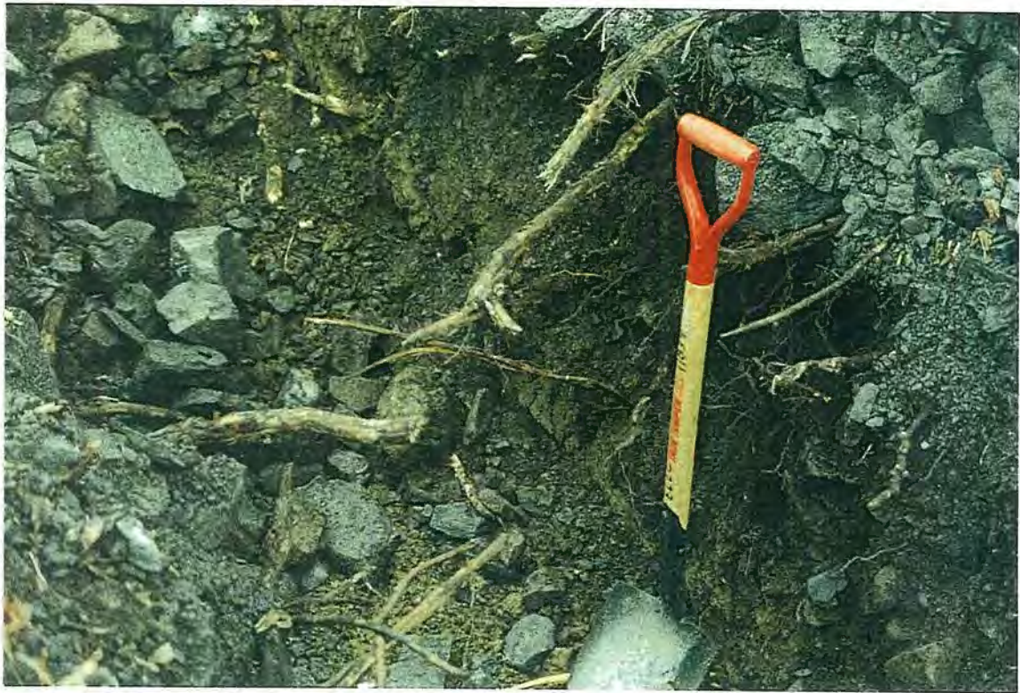
Photo 8: Racines de Saule spp. situées à la jonction des couches de perré et d'argile.
