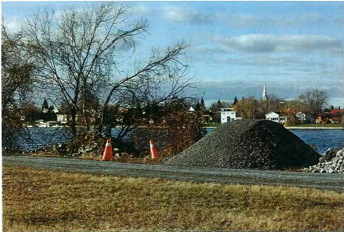
Photo 6: Pierre concassée de calibre 0-20 mm, utilisée pour remplir en partie les tranchées.
