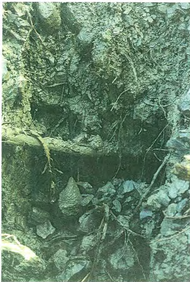
Photo 9: Racines d'Orme d'Amérique ayant pénétré dans le noyau d'argile.
