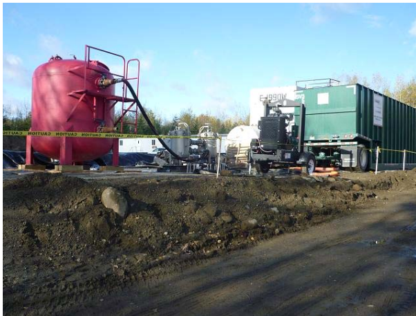
Photo 8 L'eau passe par cette unité de traitement avant son retour à la rivière.
