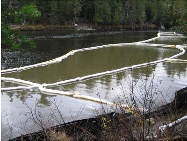
Photo 1 Les rideaux de turbidité retiennent les matières en suspension dans l'aire de travail.
