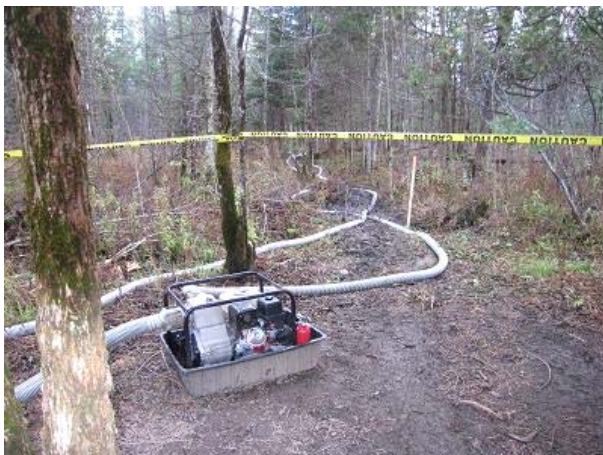
Photo 6 Des conduites acheminent le mélange d'eau et de sédiments pompés vers l'aire d'essorage.
