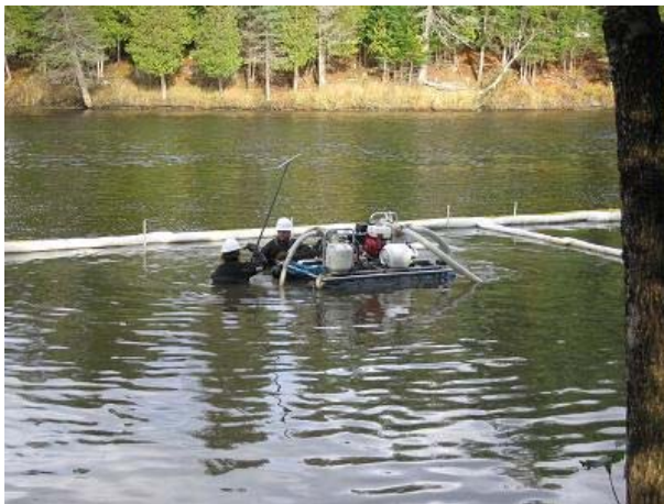
Photo 5 Dans les zones plus profondes, les pompes de la drague Sand Wand MC sont placées sur un radeau.
