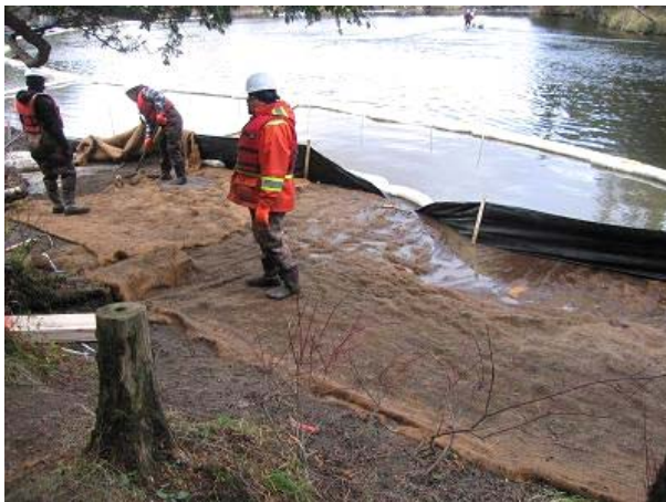
Photo 9 Dans la bordure exondée, les sédiments retirés sont remplacés par un remblai propre, recouvert et stabilisé avec un tapis de noix de coco.
