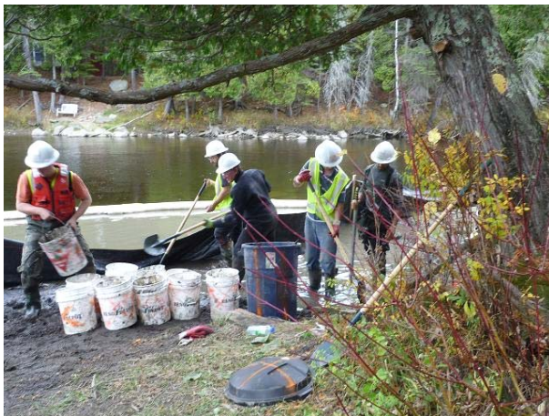
Photo 3 Les sédiments contaminés de la zone exondée sont pelletés et sortis du site à l'aide de seaux.
