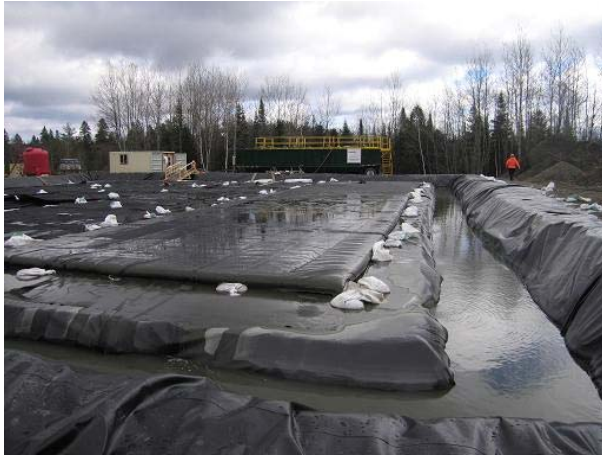
Photo 7 Dans l'aire d'essorage, le Géotube MC reçoit le mélange d'eau et de sédiments. Les sédiments sont retenus alors que l'eau passe à travers les pores du Géotube MC et est captée dans les fossés de drainage.
