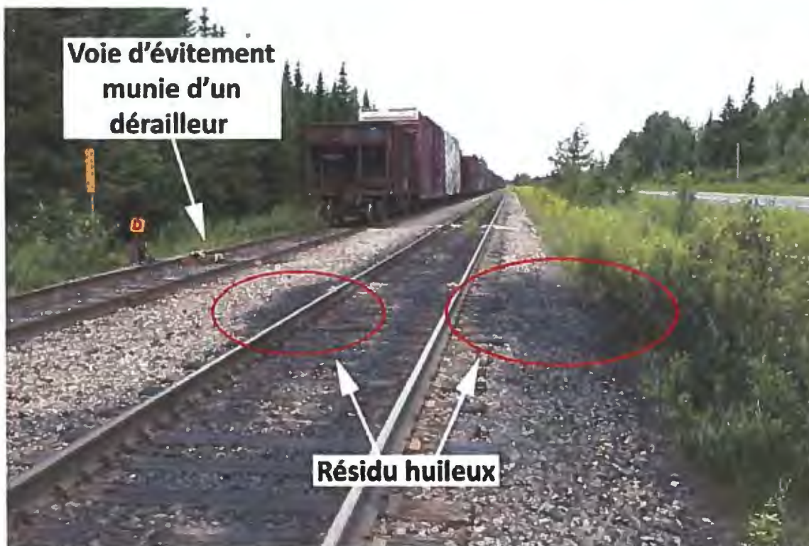
Photo 3. Résidu huileux sur le sol et la végétation à Nantes. À noter, le dérailleur sur la voie d'évitement adjacente à gauche (vue en direction ouest à partir de l'endroit où la locomotive de tête était garée sur la voie principale)
