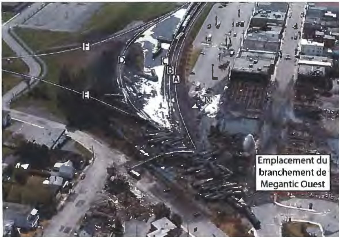
Photo 5. Vue en direction est de la disposition des voies par rapport aux premiers wagons déraillés : voie principale (A), voie de triage 1 (B), voie de triage 2 (C), voie de triage 3 (D), et les voies ouest et est du triangle de virage (E et F)
