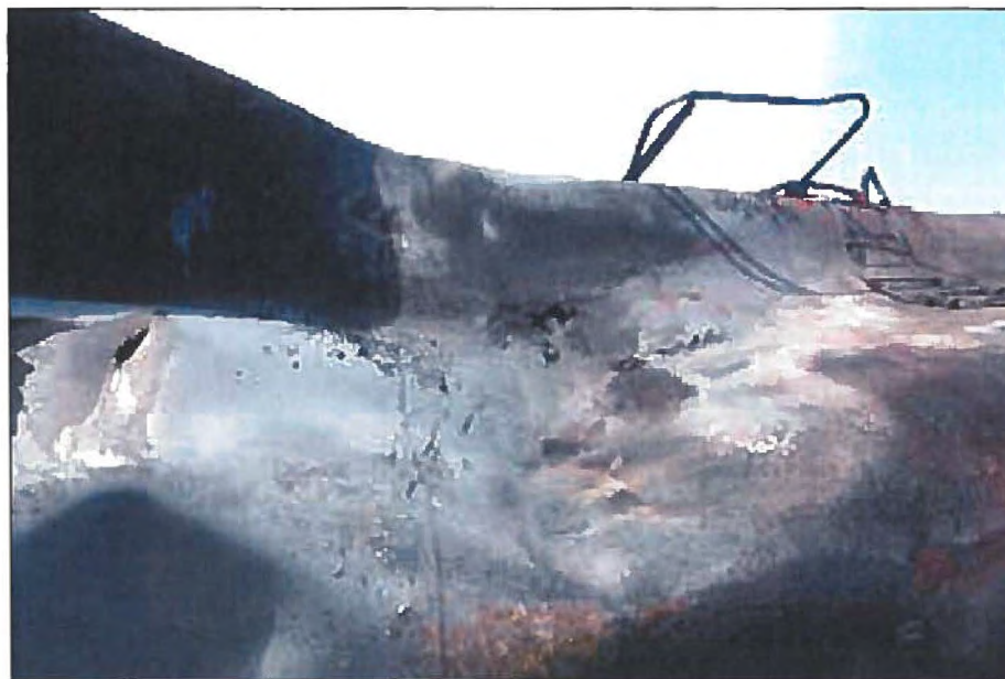
Photo 28. Perçage par brûlure
