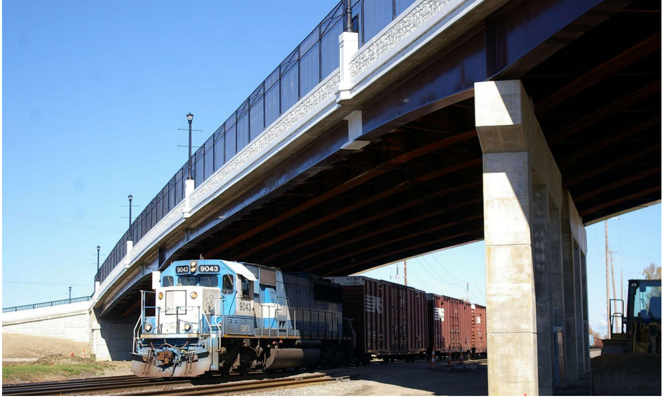
Figure 2-B Exemple d'un étagement à passage supérieur 10
