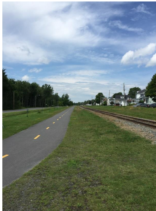
Figure 5-J Effet de coupure de la voie ferrée au centre-ville de Lac-Mégantic
