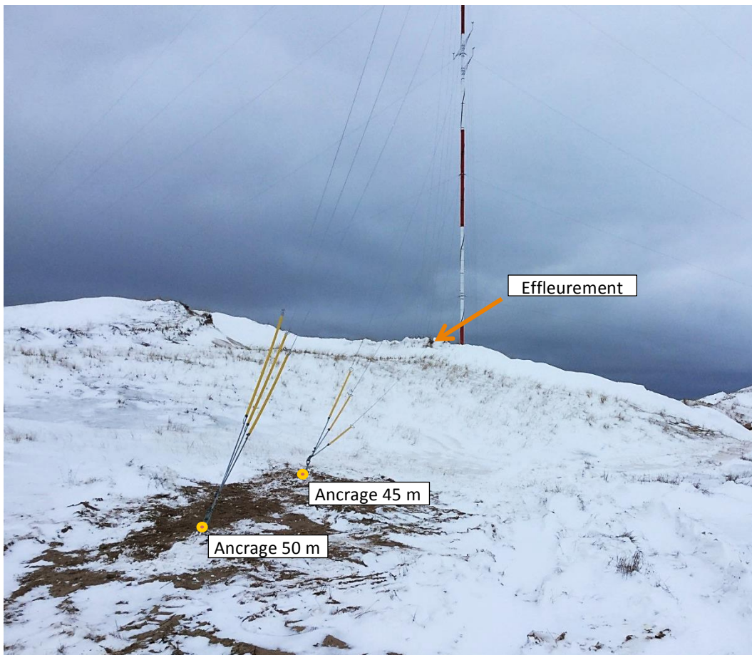
Figure 9. Ancrages à 45 m et 50 m sur l'axe sud, effleurement d'un hauban sur la crête dunaire
