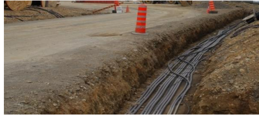
Figure 3.1 Aménagement du réseau collecteur souterrain
