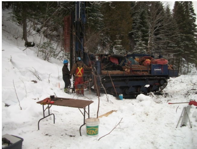
Figure 3. Exemple de foreuse
