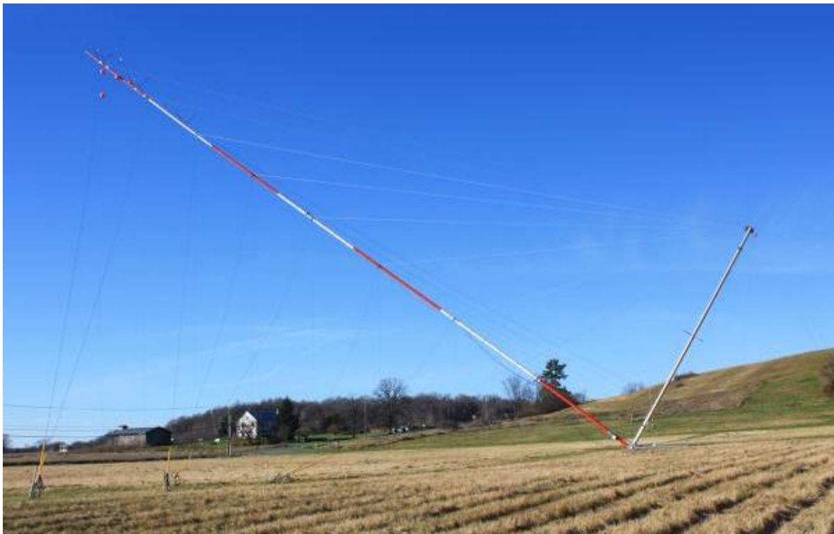
Figure 4. Érection du mât de mesure à l'aide du mât de levage (ginpole)
