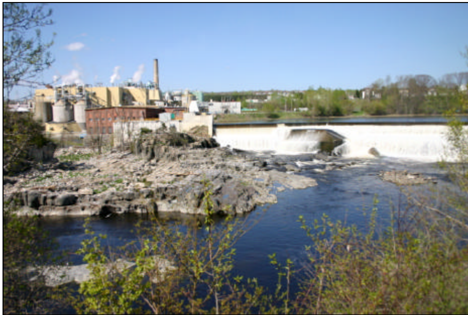
10. Barrage Larocque et bâtiment principal de l'usine; vue vers l'amont à partir de la rive ouest de la rivière Saint-François.
