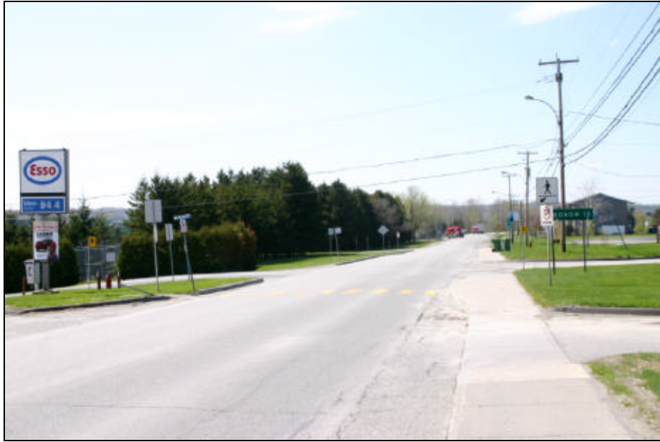
5. Route 143 et secteur de l'entrée de l'usine; vue vers le nord-ouest.
