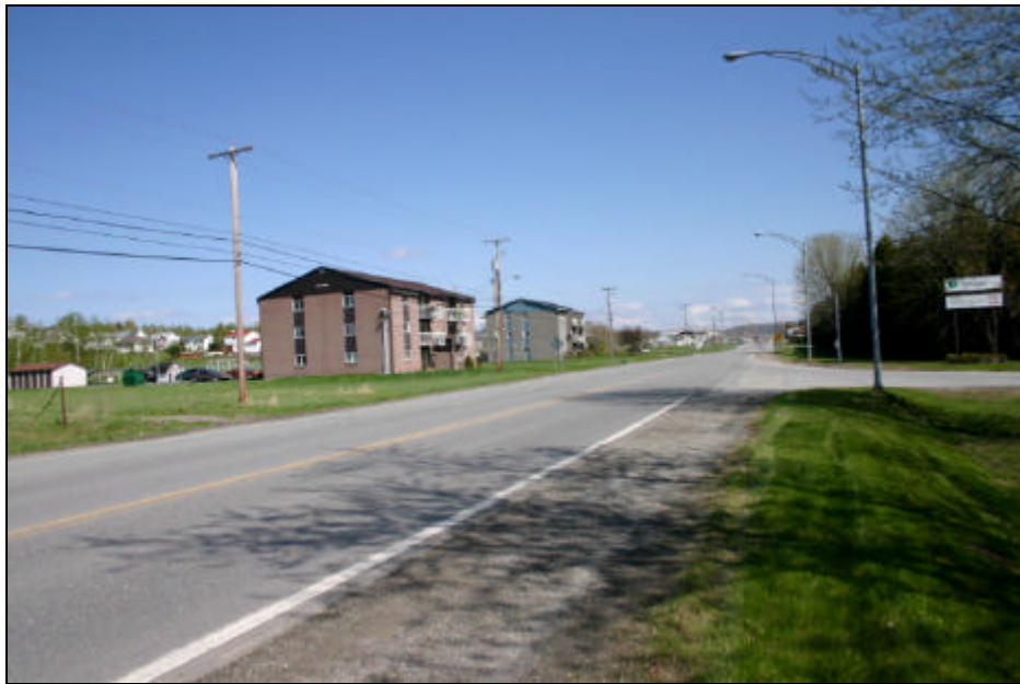
4. Entrée de l'usine sur la route 143; immeubles à logements et parc Ernest-Bergeron; vue vers le sud-est.
