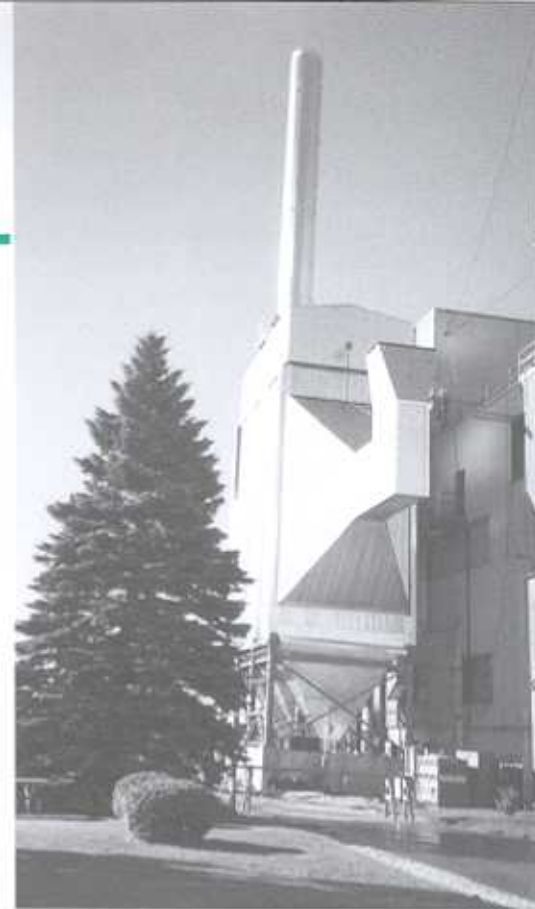
Précipitateur électrostatique. Appareil qui capte les particules solides ou liquides, les empêchant ainsi de se répandre dans l'air.
