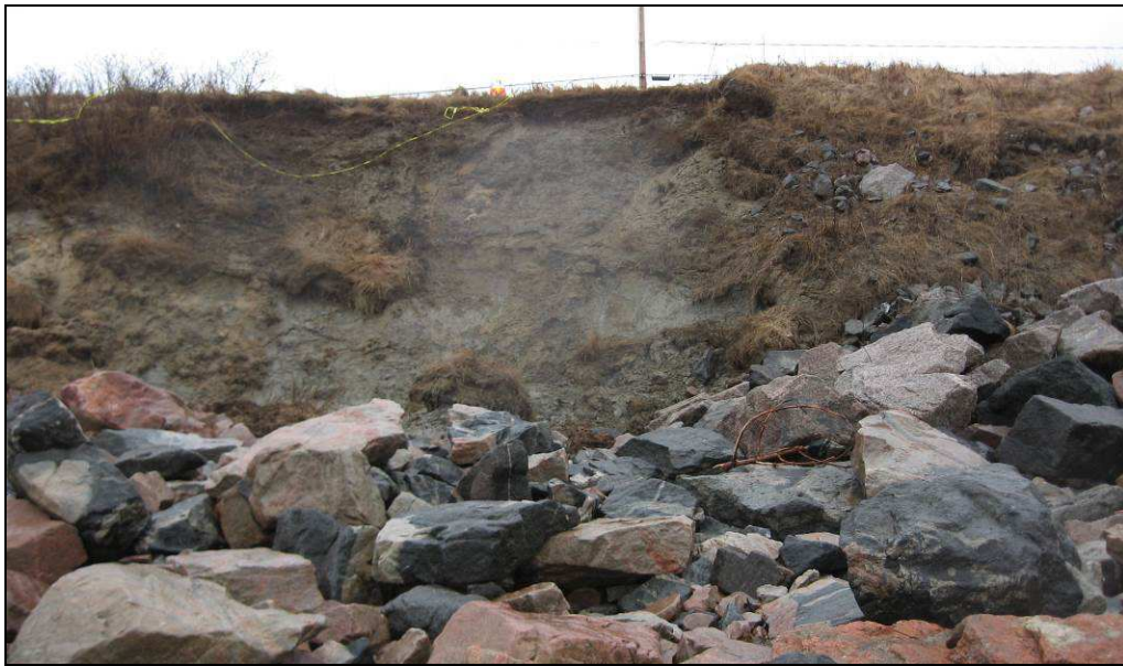
Figure 3 : Vue du glissement de terrain situé plus ou moins en face du 97, rue Labrie (Glissement B : photo du MSP).
