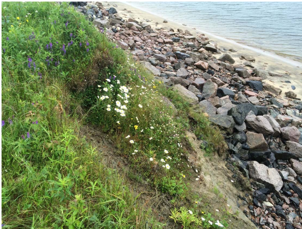
Figure 2 : Végétation herbacée en haut de talus – côté ouest du quai
