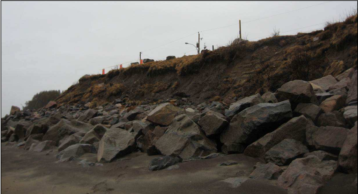
Figure 6 : Vue de la zone de glissements de terrain superficiels affectant la falaise au niveau du rond-point situé à l'entrée du Parc Nature (Glissement D : photo du MSP).
