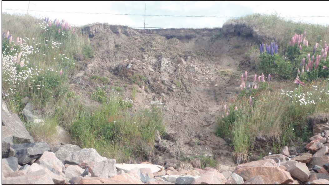
Figure 10 : Vue de la falaise affectée par un glissement de terrain en face du 101 de la rue Labrie, en juillet 2013.
