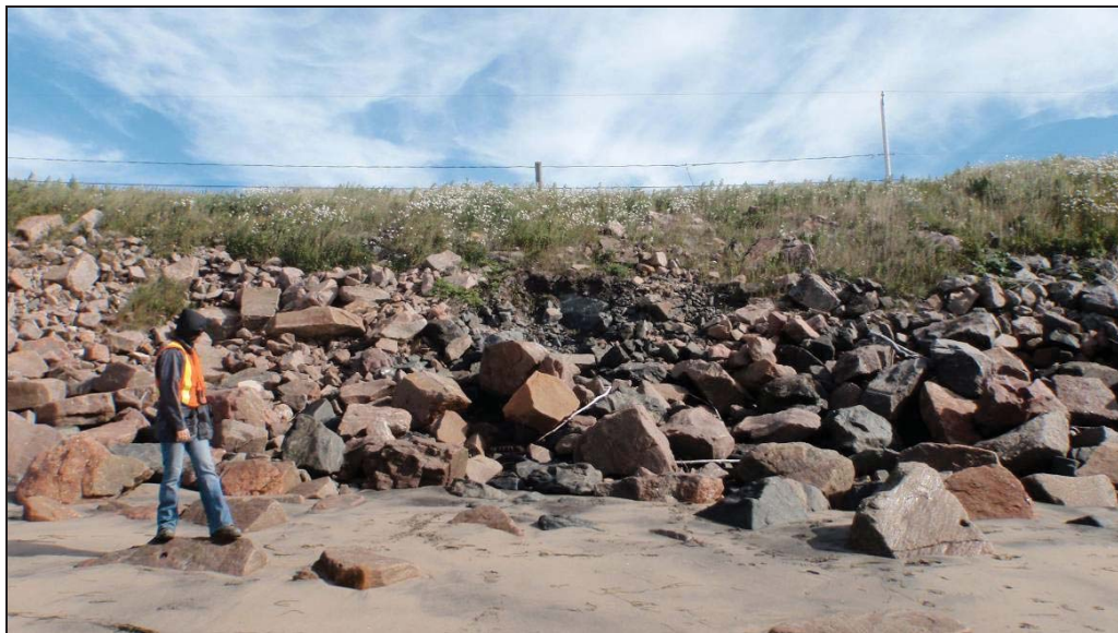
Figure 4 : Signe d'érosion au-dessus de l'enrochement et instabilités de surface devant l'adresse civique du 105, rue Labrie (11 juillet 2013).
