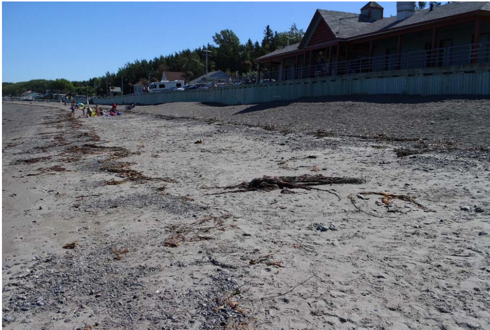
Figure 9 : Plage de Saint-Luce stabilisée par une recharge de plage, 5 septembre 2016
