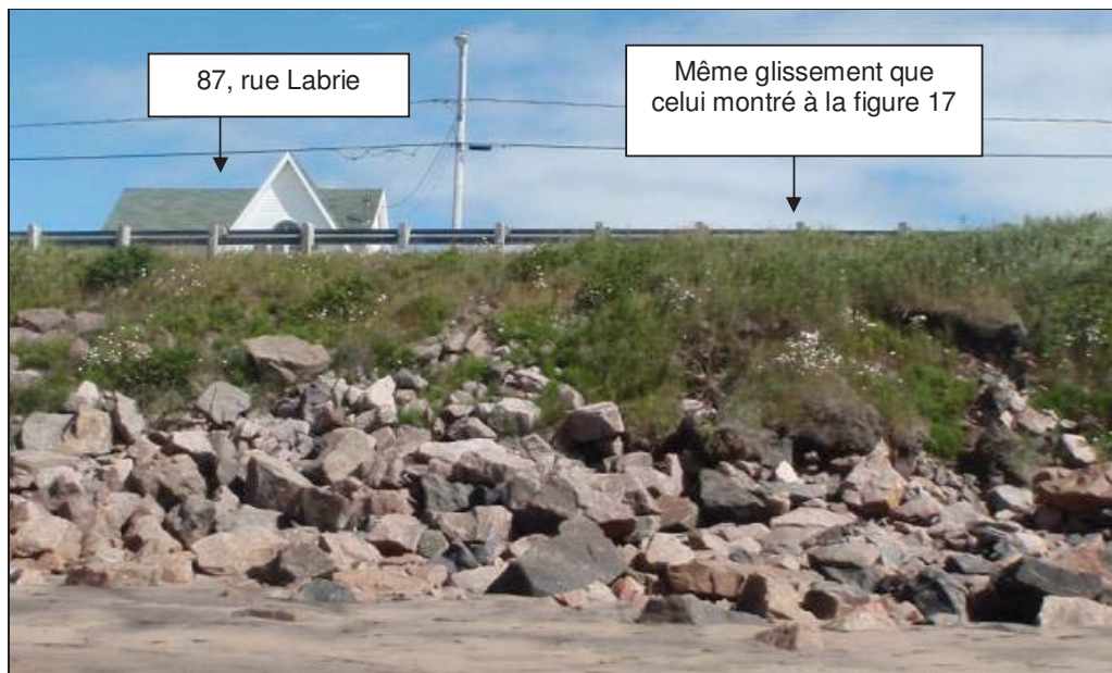
Figure 18 : Vue de la falaise, plus ou moins en face du 87 de la rue Labrie, en juillet 2013.
