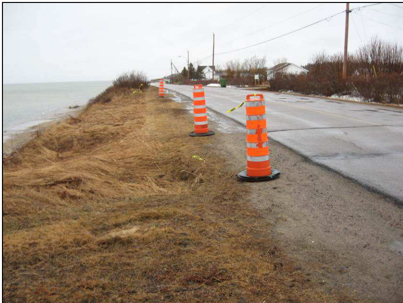
Figure 4 : Périmètre de sécurité au sommet de la falaise, plus ou moins en face des adresses civiques 97 et 101, rue Labrie (Glissements B et A : photo du MSP).
