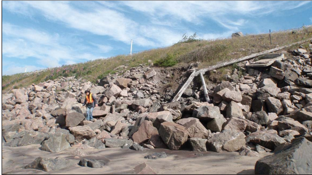
Figure 3 : Signe d'érosion au-dessus de l'enrochement et instabilités de surface devant l'adresse civique du 109, rue Labrie (11 juillet 2013).
