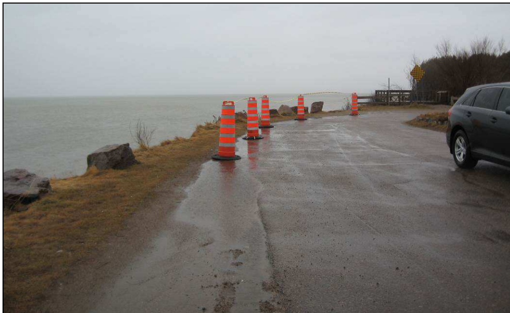
Figure 7 : Périmètre de sécurité en sommet de talus au niveau du rond-point situé à l'entrée du Parc Nature (photo du MSP).
