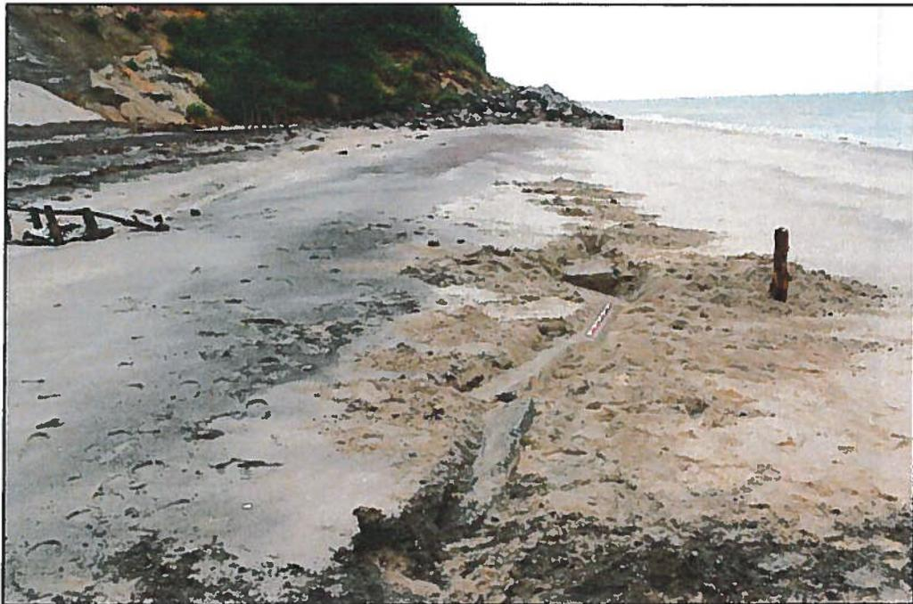
Photo 14 Blocs de béton en lien avec les pièces de bois verticales, secteur 2 (PATR12N05-16)
