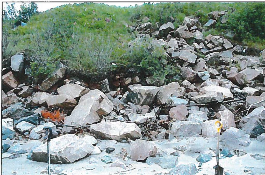
**Photo 8** Détail d'un empierrement du talus avec la présence d'un tuyau en acier ondulé dont l'extrémité est dégagée (en haut à gauche), secteur 1 (PATR12N05-34)
