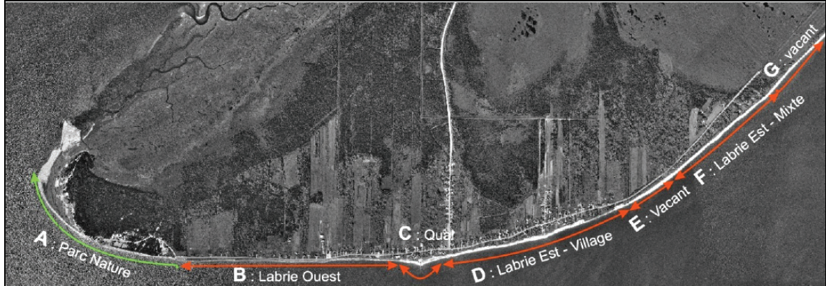
Figure 3-1 : Segments de la côte de Pointe-aux-Outardes - Mesures de stabilisation des berges
