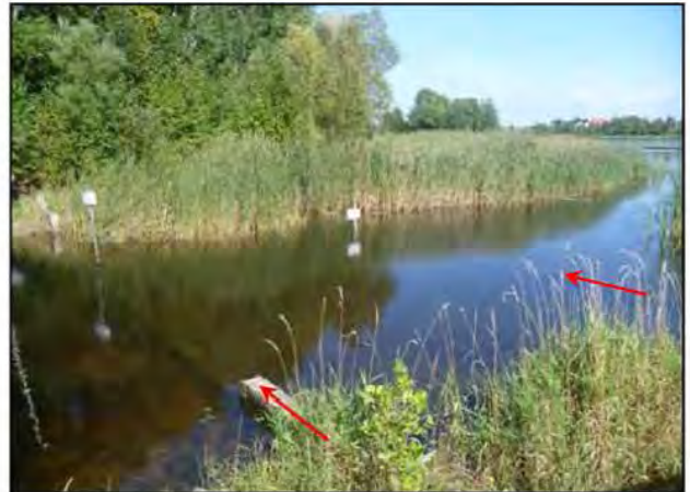
Photo 10. 16 septembre 2015 (101,12 m) Vue des seuils en bois et de l'habitat en période d'étiage
