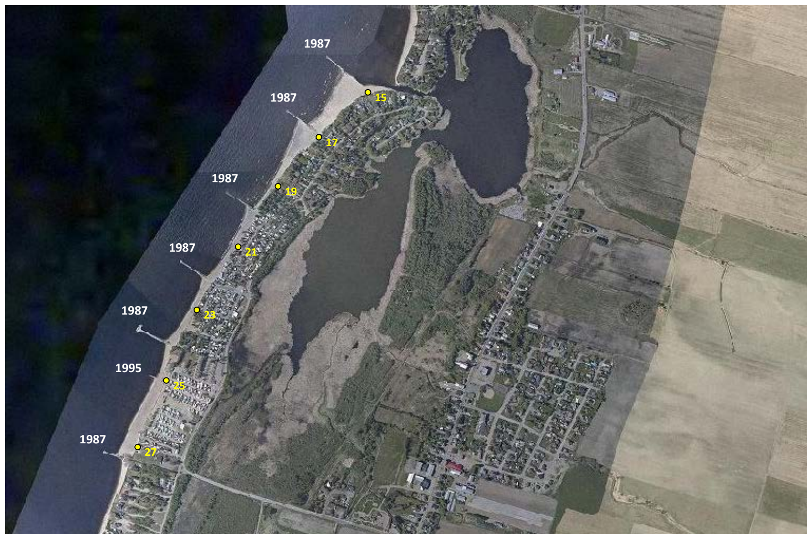
Figure 2.6: Ouvrages de stabilisation des berges à St-Gédéon
