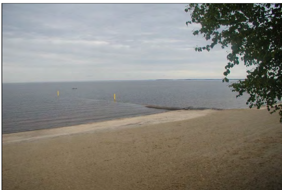
Photo 13 : Géotube, Métabetchouan-Lac-à-la-Croix, site 94.03.01
