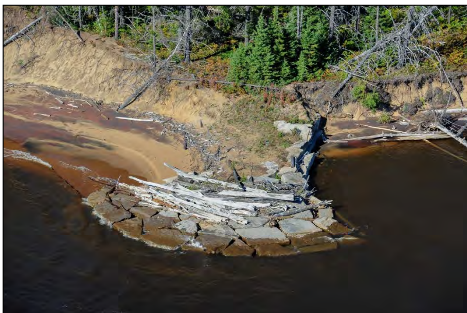
Photo 10 : Épi en éventail, Pointe-Taillon, site 91.14.01
