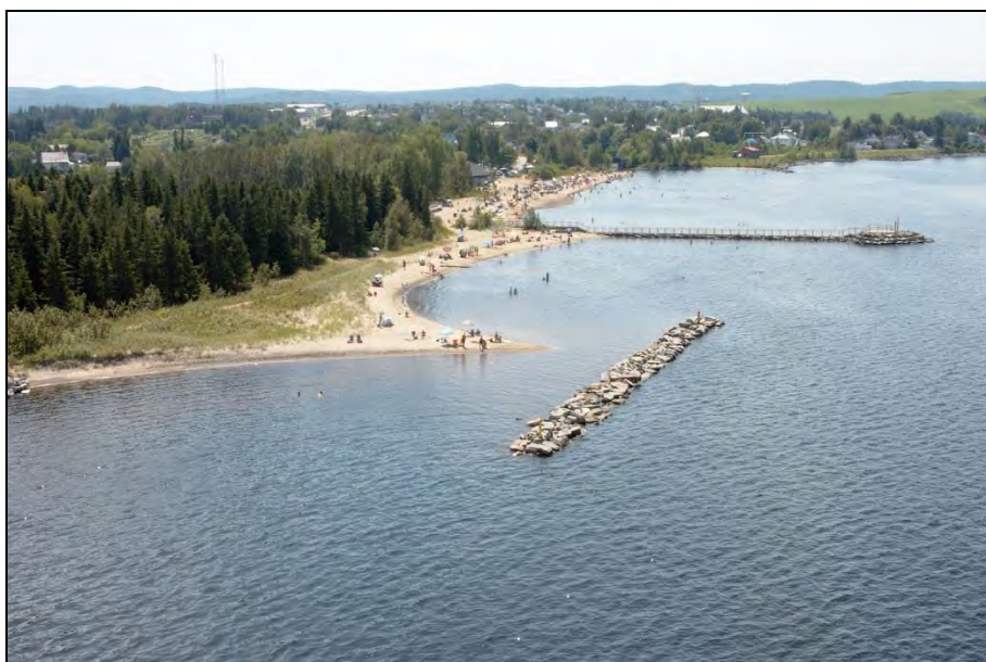
Photo 14 : Épi et brise-lames, Le Rigolet de Métabetchouan-Lac-à-la-Croix, site 91.03.04
