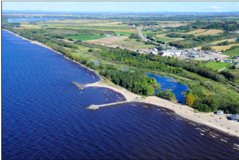
Photo 3 : Épi et brise-lames, Le Rigolet de Métabetchouan-Lac-à-la-Croix, site 91.03.04
