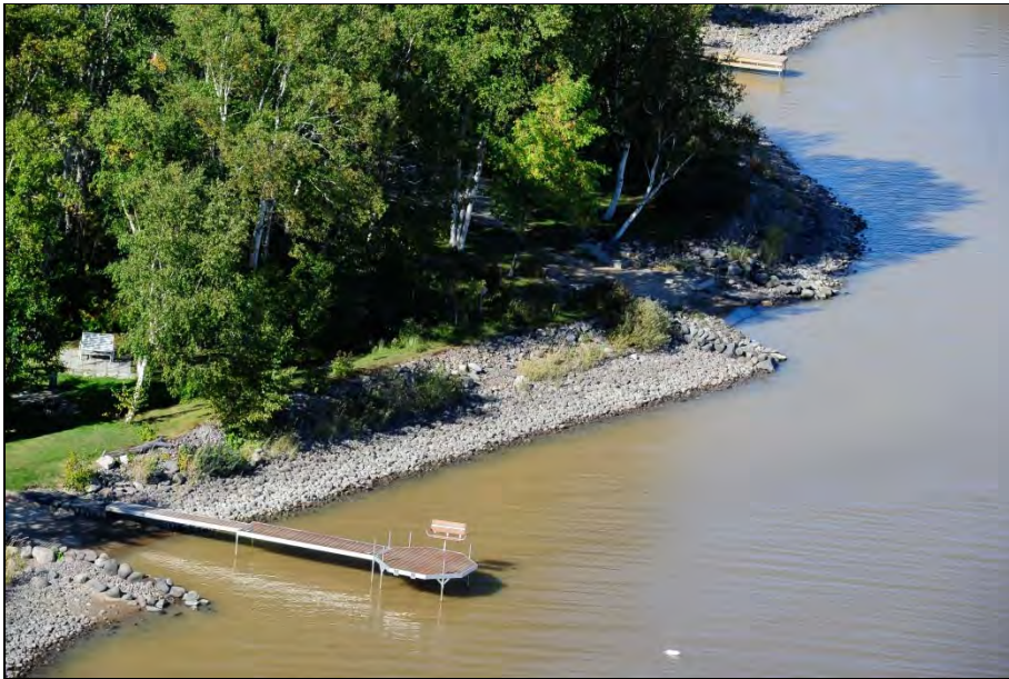
Photo 11 : Empierrement 25-150 mm, Saint-Henri-de-Taillon, site 2001.15.01
