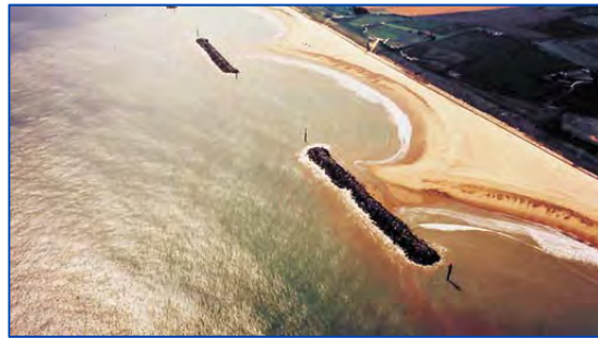
Figure 3-18. Exemple de brise-lames détachés conventionnels (source : ImgBuddy [www.imgbuddy.com]).
