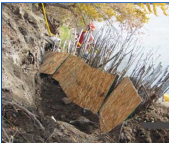
Figure 4-17. Aménagement de lits de plançons à travers un enrochement conventionnel (source : Terra Erosion)
