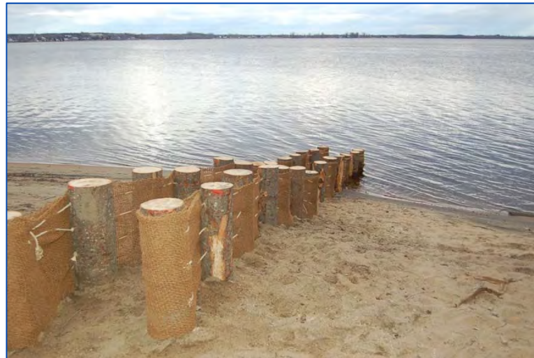
Figure 3-13. Exemple d'un épi perméable (pieux de bois reliés par une membrane, Île Saint-Quentin, Québec)
