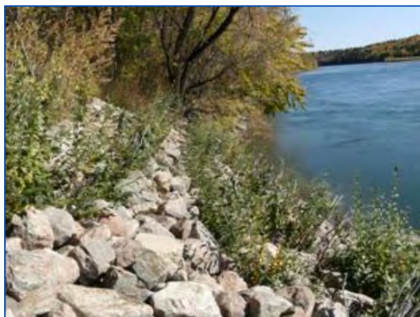
Figure 4-17. Aménagement de lits de plançons à travers un enrochement conventionnel (source : Terra Erosion)
