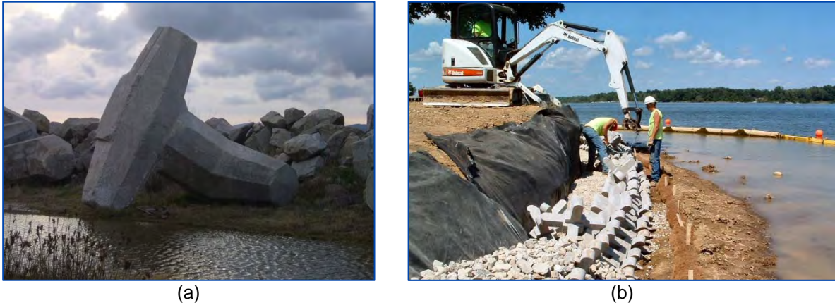
Figure 4-3. Exemple d'éléments préfabriqués : (a) Dolos et (b) A-Jacks (source : City of Columbus, Ohio [www.columbus.gov])
