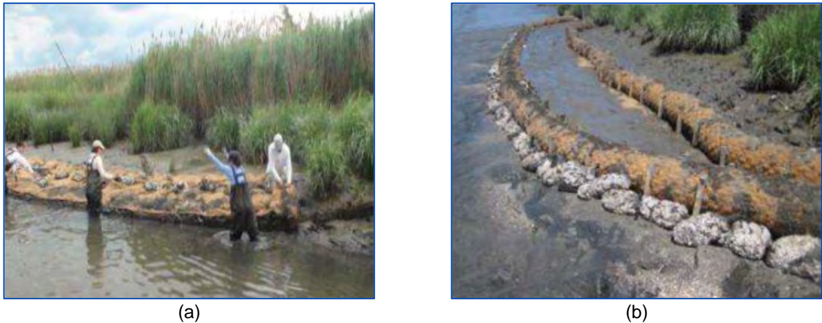
Figure 4-21. Aménagement de boudins colonisés par des végétaux et des mollusques (DELSI 2011)
