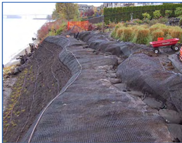
Figure 4-10. Sacs Envirolok® recouverts d'une géogrid
