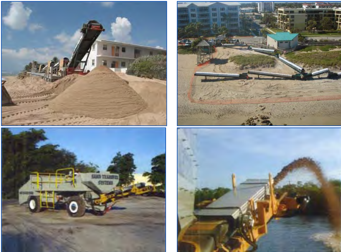
Figure 3-5. Exemples de systèmes de convoyeurs pour acheminer les sédiments sur la plage (source : Coastal Systems International [ www.coastalsystemsint.com ] et Sand Transfer Systems [ www.sandtransfersystems.com ])
