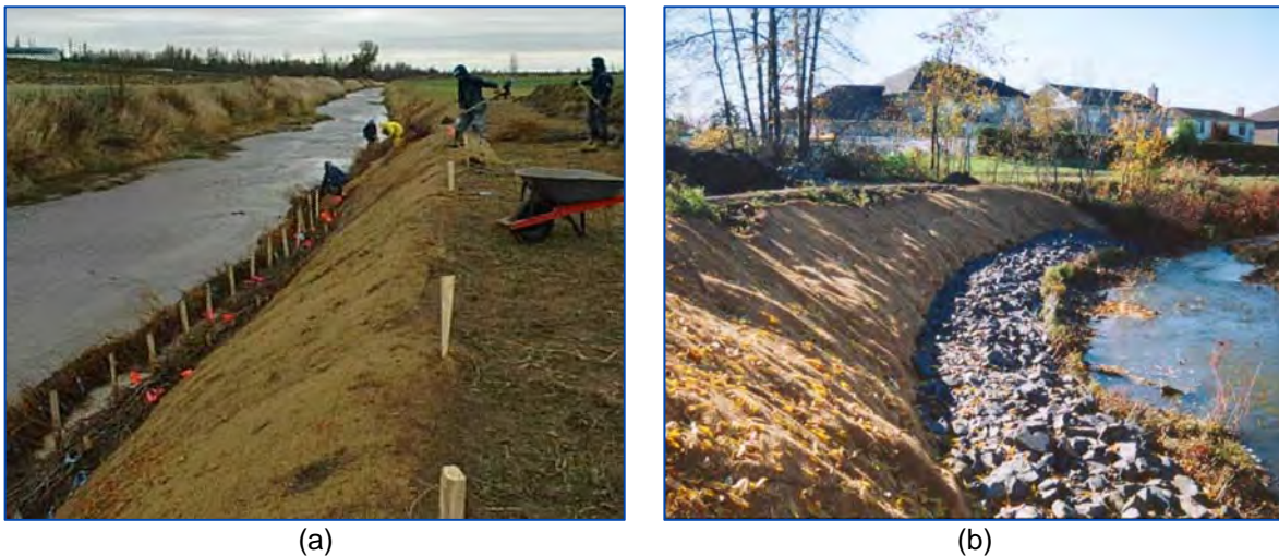
Figure 4-18. Mise en place de fascines (a) en branches et (b) en pierres
