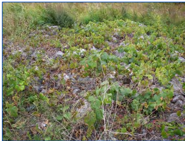
Figure 4-14. Exemple d'enrochements végétalisés à Saint-Sulpice (source : WSP)
