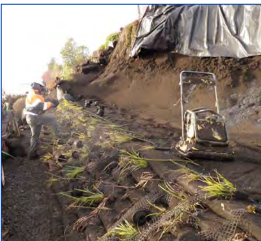
Figure 4-16. Aménagement d'un lit de plançons (source : Envirolok)
