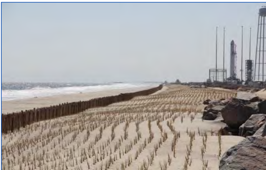
Figure 3-25. Plantation aménagée sur le haut de plage
