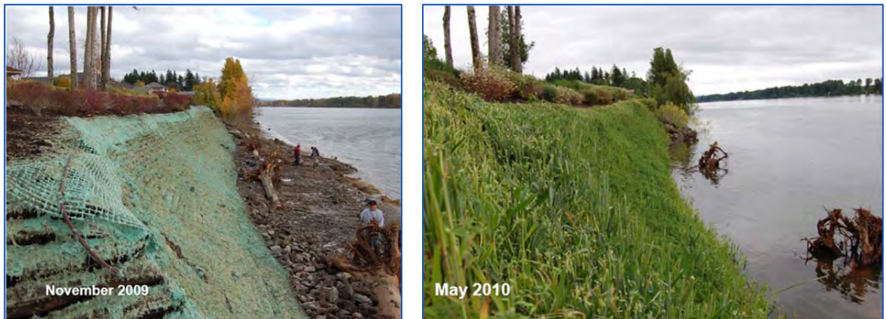
Figure 4-8. Exemple de mur de soutènement végétalisé Envirolok®
