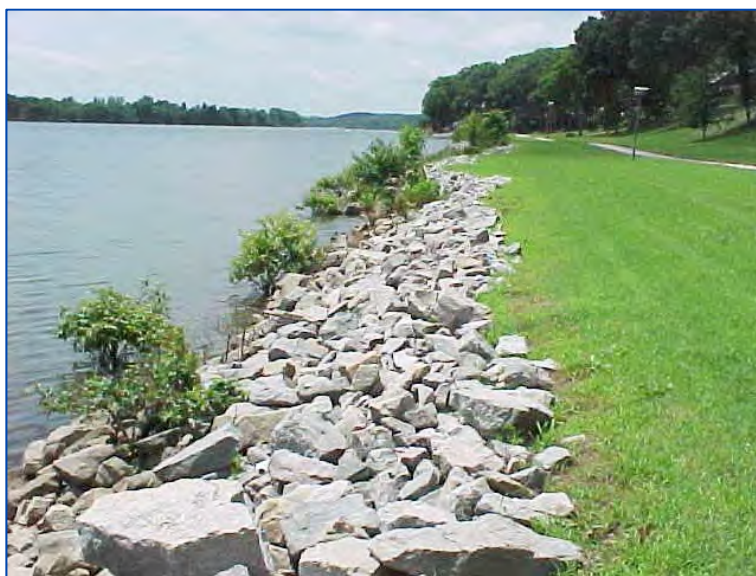
Figure 4-2. Exemple de perrés conventionnels (source : USACE [ www.orn.usace.army.mil ])
